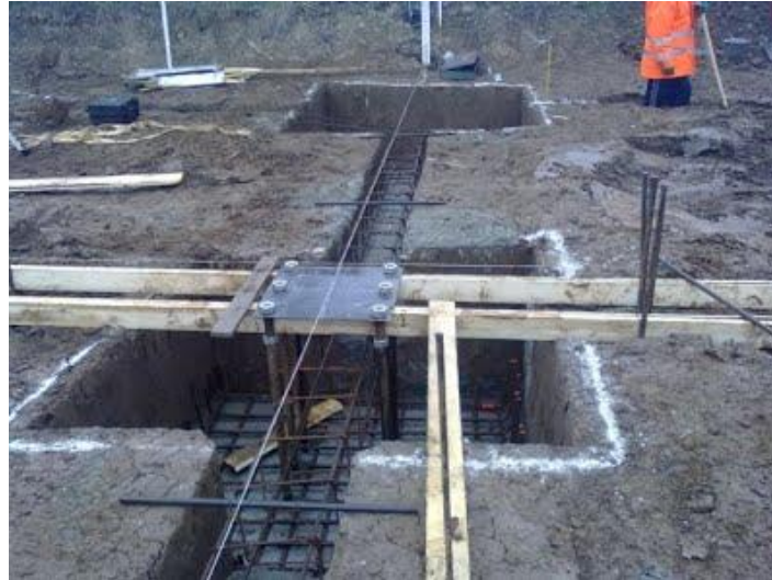
Imagen 7.1 Habilitado de refuerzo en traves de liga y dados para la cimentación de un Rack
