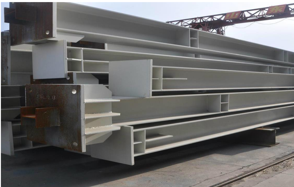
Imagen 7.4 Almacenaje de columnas de Rack de Tuberías
