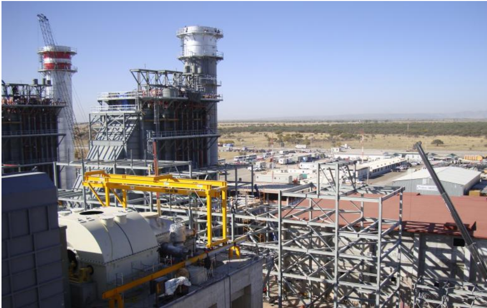
Imagen 7.3 Montaje de marcos transversales de Rack de Tuberías
