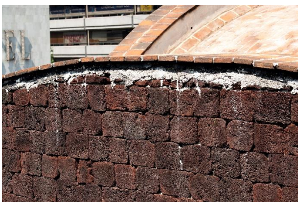
Fig. 224 Cemento sobre el tezontle al colocar el enladrillado de las bóvedas (fotografía: Brian Nolasco, 2018).
