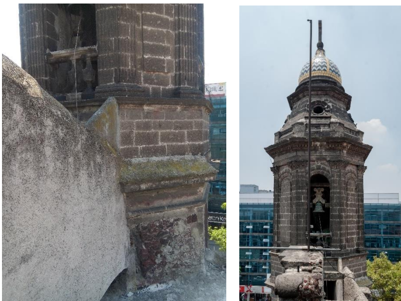
Fig. 90 Detalle del cambio de materiales en la torre sur (fotografía: Leticia Domínguez, 2018). Fig. 91 Remate de la torre sur (fotografía: Brian Nolasco, 2018).
