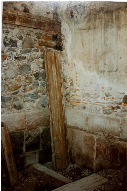
Fig. 203 Paramentos de mampostería (APSMA, reproducción fotográfica: Leticia Domínguez, 2018).
