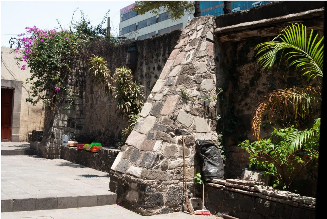
Fig. 106 Contrafuertes de mampostería con cemento al interior de la barda sur (fotografía: Brian Nolasco, 2018). Fig. 107 Nicho de ladrillo con rajueleado (fotografía: Brian Nolasco, 2018).
