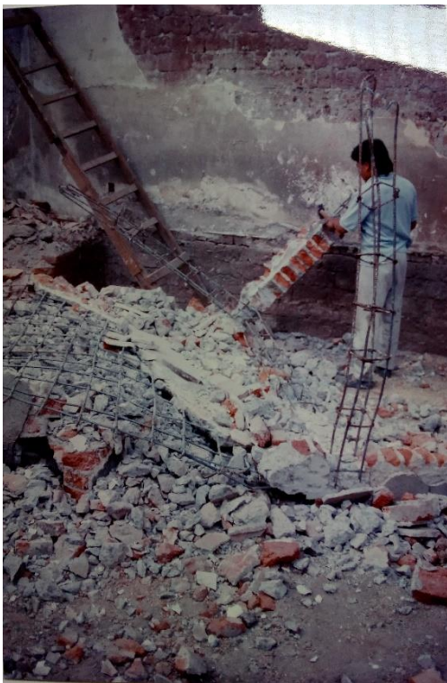
Fig. 194 Demolición del cuarto de concreto (APSMA, reproducción fotográfica: Leticia Domínguez, 2018). Fig. 195 Demolición del cuarto de concreto (APSMA, reproducción fotográfica: Leticia Domínguez, 2018). Fig. 196 Demolición del cuarto de concreto con varillas y ladrillos (APSMA, reproducción fotográfica: Leticia Domínguez, 2018).
