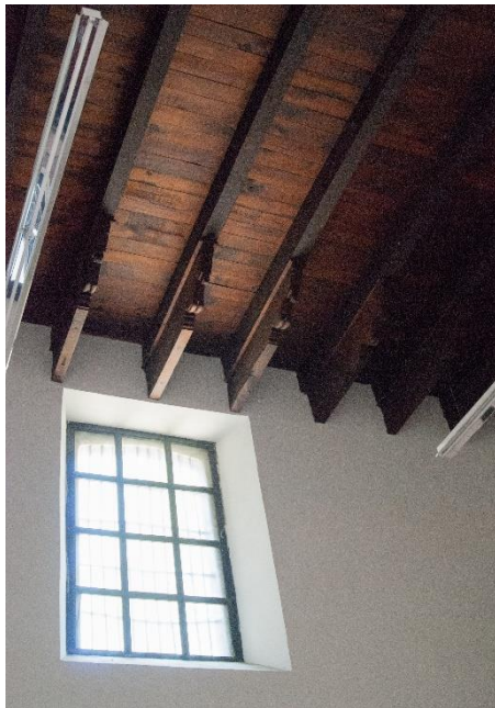
Fig. 209 Ventana y techo de vigería de la capilla de Nuestra Señora del Pilar (fotografía: Brian Nolasco, 2018).
