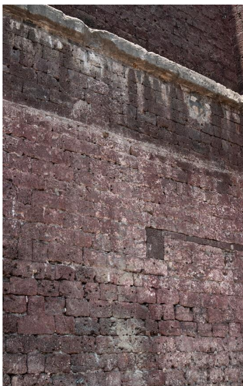
Fig. 141 Huella de la estructura de concreto (fotografía: Brian Nolasco, 2018).
