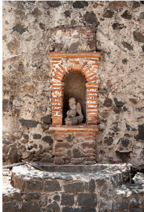
Fig. 106 Contrafuertes de mampostería con cemento al interior de la barda sur (fotografía: Brian Nolasco, 2018). Fig. 107 Nicho de ladrillo con rajueleado (fotografía: Brian Nolasco, 2018).
