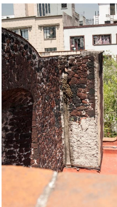
Fig. 177 Restauración con yeso las partes de cantera de la nave del templo (fotografía: Brian Nolasco, 2018).
