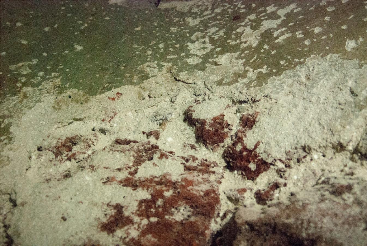
Figura 14. Detalle del aplanado del interior de la torre norte (fotografía: Brian Nolasco, 2018).
