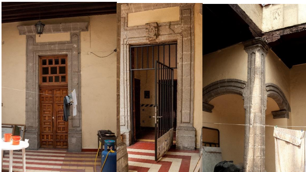
Fig. 70 Dintel de una de las puertas de la casa parroquial (fotografía: Brian Nolasco, 2018). Fig. 71 Detalle del acceso a la casa cural en el segundo piso (fotografía: Brian Nolasco, 2018). Fig. 72 Arcos estructurales en la planta alta de la casa cural (fotografía: Brian Nolasco, 2018).
