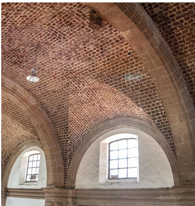
Figura 6. Bóveda de arista, detalle de las hiladas (fotografía: Brian Nolasco, 2018).
