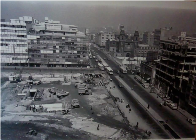
Fig. 166 Construcción de la estación del metro Pino Suárez (Fototeca Constantino Reyes Valerio, s/f)
