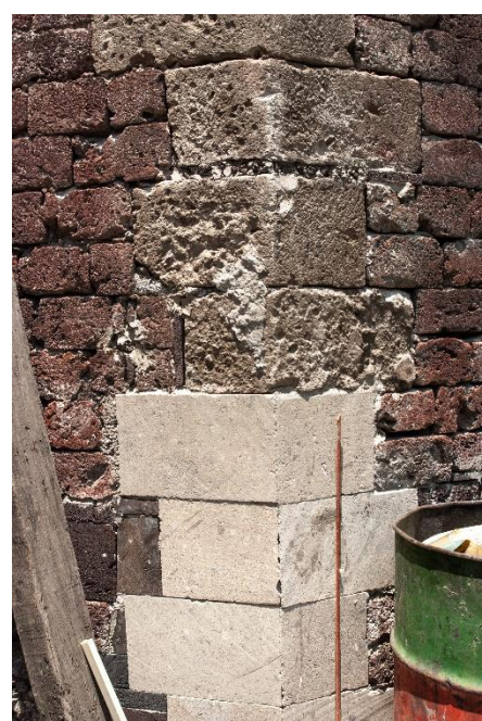
Fig. 177 Restauración con yeso las partes de cantera de la nave del templo (fotografía: Brian Nolasco, 2018).
