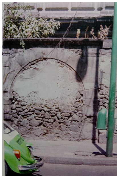
Fig. 157 Desplome de la barda sur (fotografía: Brian Nolasco, 2018).
