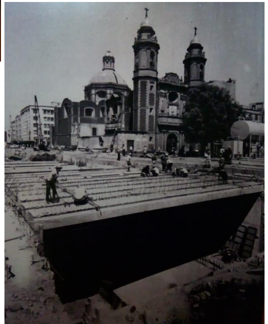
Fig. 167 Construcción de la estación del metro Pino Suárez (Fototeca Constantino Reyes Valerio, s/f)
