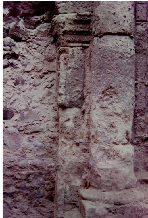
Fig. 191 Cantera erosionada de la portada lateral del templo (fotografía: Brian Nolasco, 2018).
