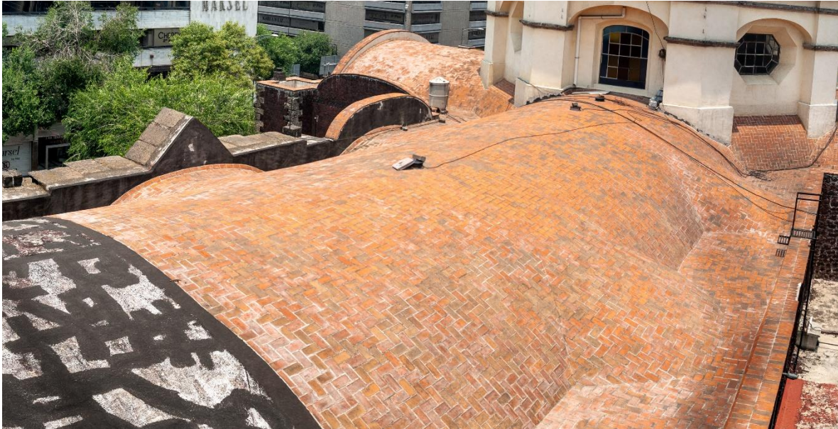
Figura 7. Recubrimiento de las bóvedas del templo de ladrillo y chapopote (fotografía: Brian Nolasco, 2018).
