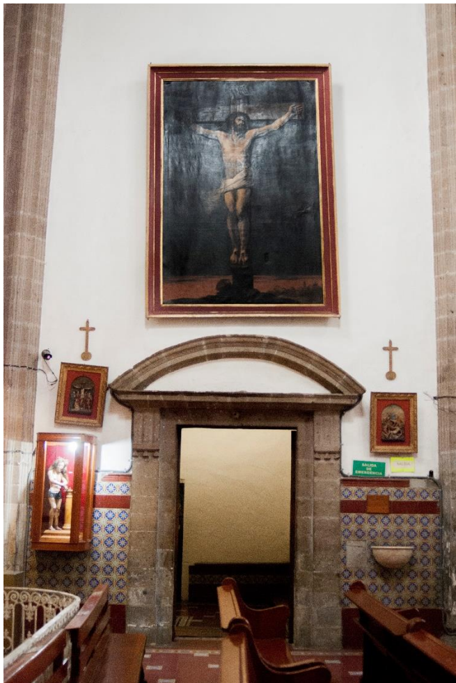
Fig. 100 Dintel en el acceso de la sacristía (fotografía: Brian Nolasco, 2018).
