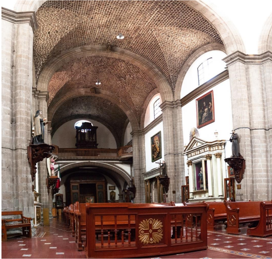
Figura 9. Interior del templo con vista al coro (fotografía: Brian Nolasco, 2018).
