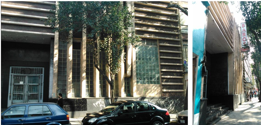
Tipo de construcción: Baños. Situación: Abandonado. Ubicación: Calle Santa María La Ribera, col. Sta. María la Ribera, CDMX. Autor: Ariadne Hernández
