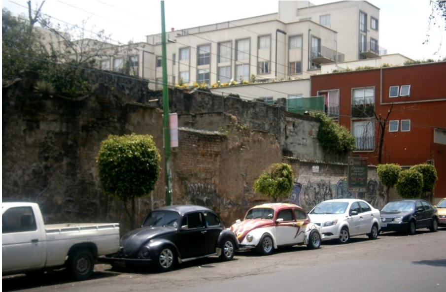
Vista de la colindancia sur de El Pensil Mexicano, donde se observa el acceso principal (volumen color rojo ladrillo) al edificio de vivienda que rodea el predio. Ubicación fotografía: Calle Lago Chiem, col. Ahuehuetes Anáhuac, CDMX. 2014. Autor: Ariadne Hernández.
