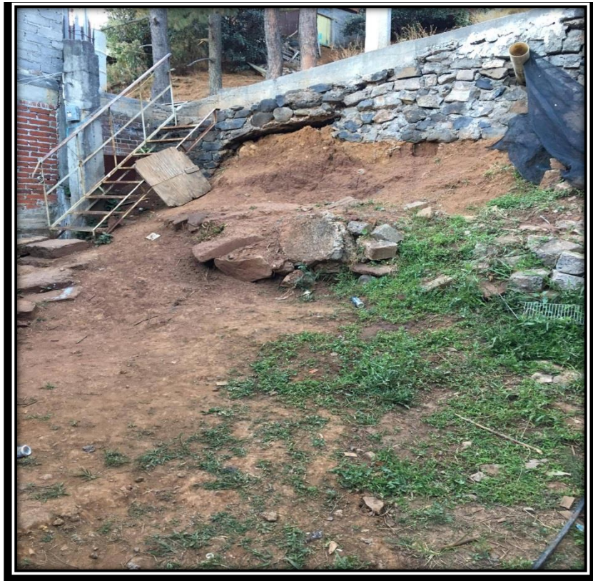
Imagen 3.1 Interior de la unidad habitacional representando el talud a retener.
