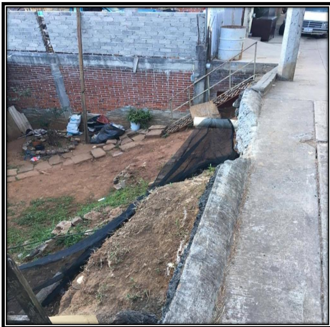
Imagen 5.2 Frente de la unidad habitacional, lugar indicado para la construcción del Muro.
