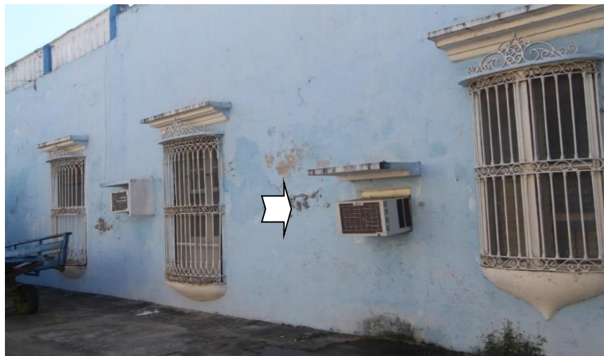
FOTO 2. Equipos de aire acondicionado en edificios de Tlacotalpan.
