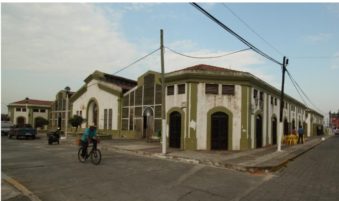
Vista General de fachada oriente. Foto DRB.
