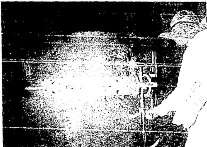
CORTE DE LA CABEZA DE UN TRAMO DE PILOTE.
