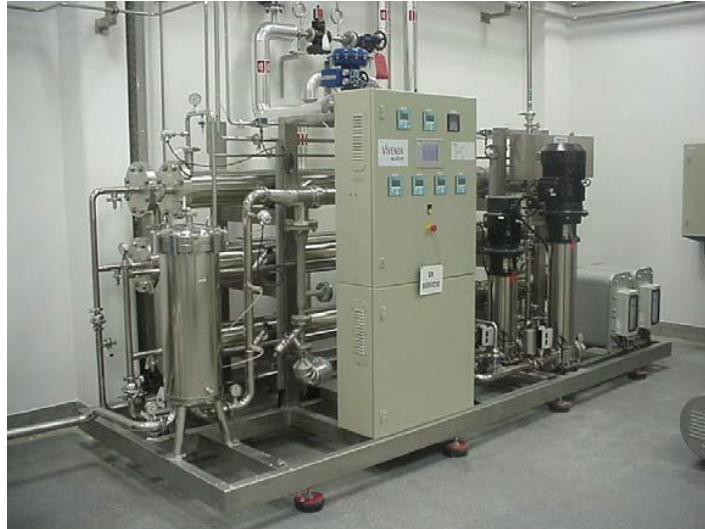
Figura 1.9. Producción de agua purificada combinando ósmosis inversa y electrodeionización [9].
