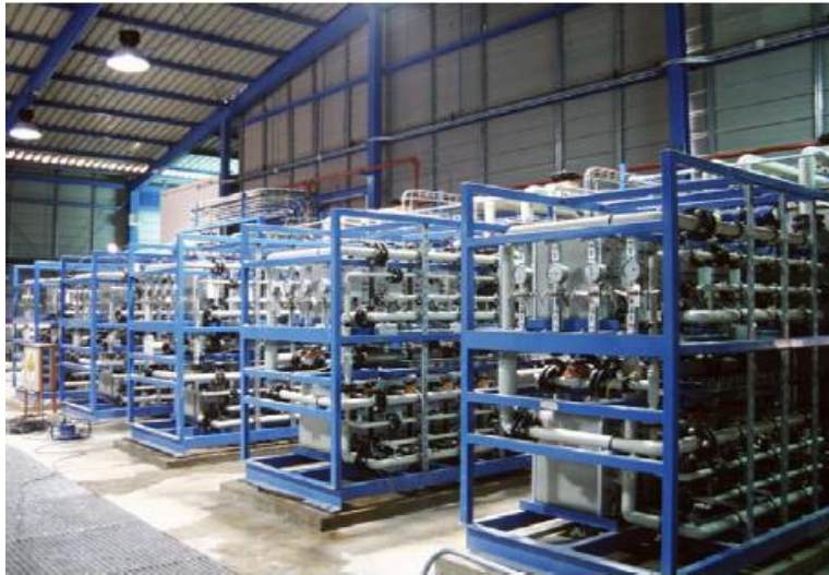
Figura 1.10. Equipos modulares de electrodeionización (EDI) para producción de agua para calderas de alta presión [9].
