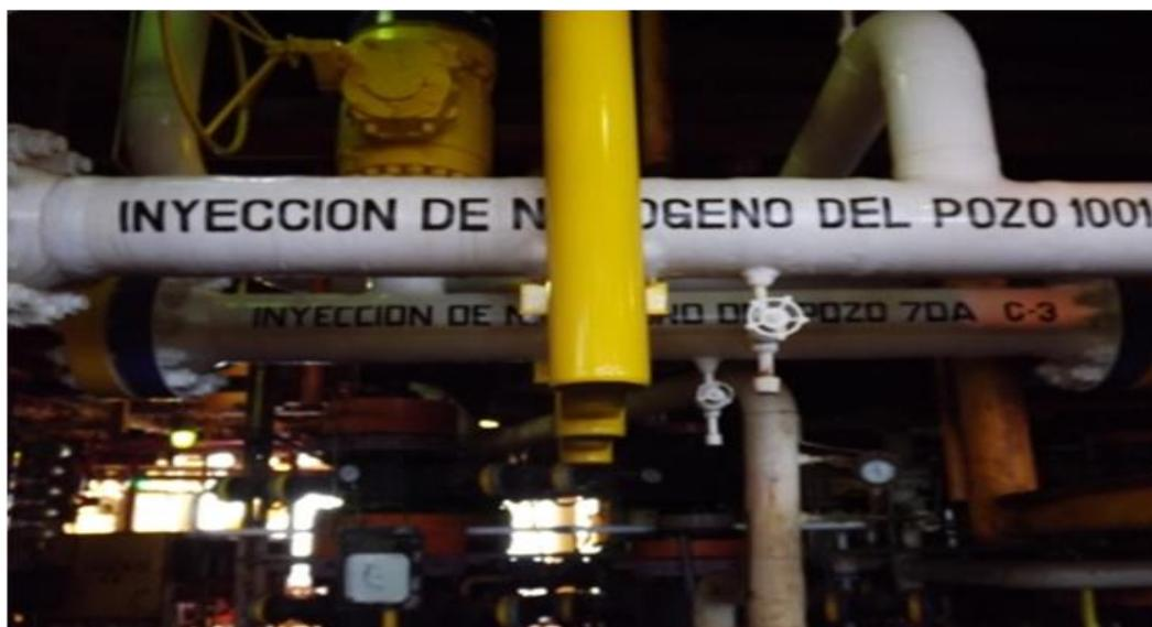
Fig. 5. 4 Cabezales de Inyección de N<sub>2</sub>, pozos 1001 y 7DA (PEMEX, 2018)
