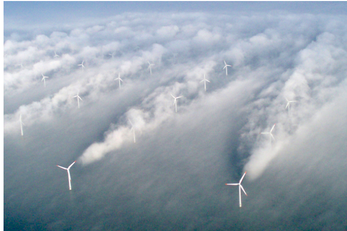
Figura 2 .5: Efectos de estela en aerogeneradores. Figura tomada de [18].
