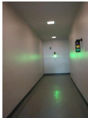
Pasillo de acceso acelerador lineal
