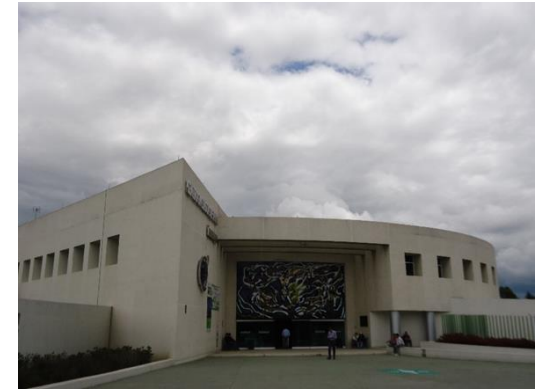
Vista de calle hospital oncológico ISSEMyM Toluca
