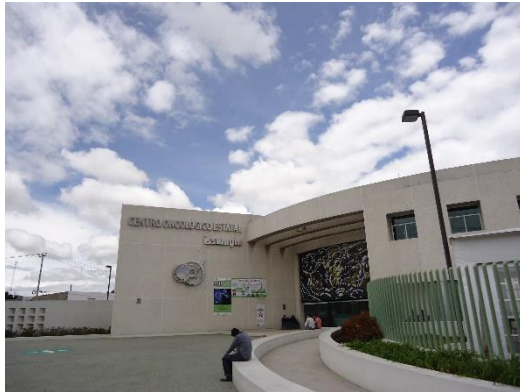
Vista de calle hospital oncológico ISSEMyM Toluca
