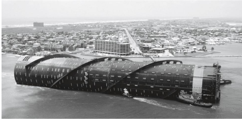
Figura 2.9 Plataforma spar remolcada (Leffler et al., 2011)
