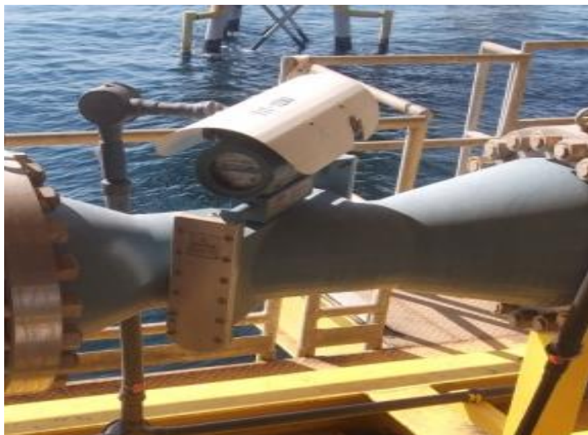
Figura 3.17 Medidor ultrasónico (Pemex Exploración y Producción, 2014)
