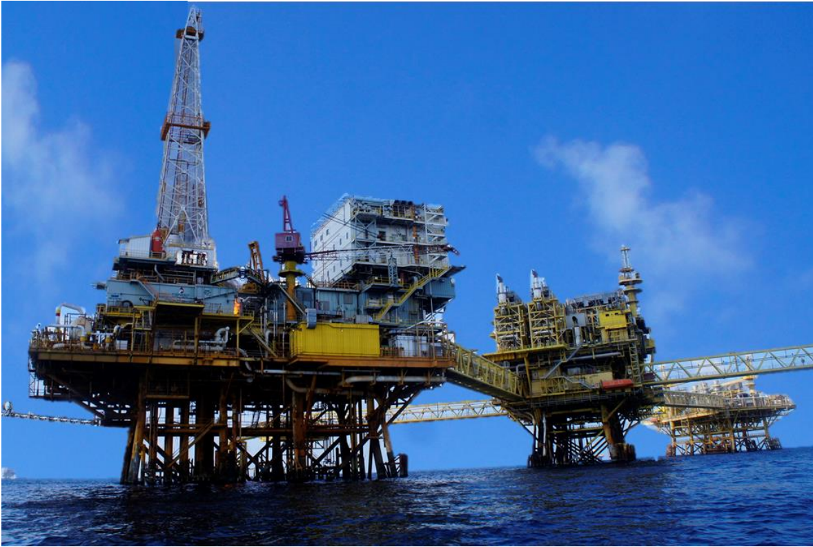
Figura 3.10 Centro de Proceso, donde a la izquierda se encuentra la plataforma de perforación, en el centro la de producción y en el fondo la de generación eléctrica (Pemex Exploración y Producción, 2013)
