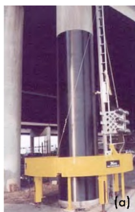
a) Instalación automática a una columna de concreto
