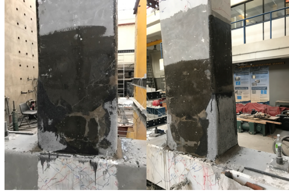
b) Reparación de la conexión viga-columna con el sistema PRFC
