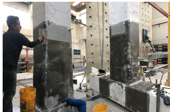
d) Técnica manual, aplicación en húmedo
