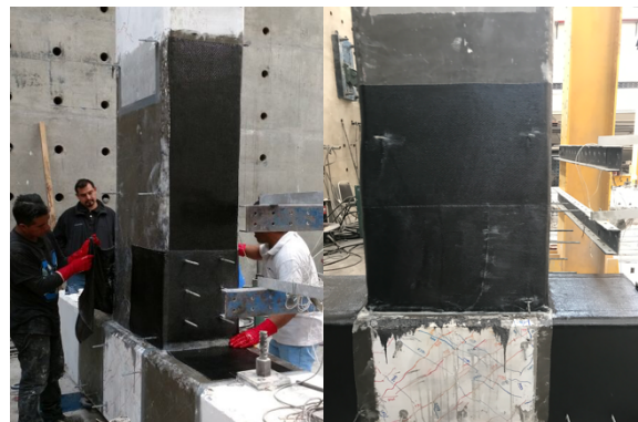
f) Reforzamiento de la conexión viga-columna con el sistema PRFC
