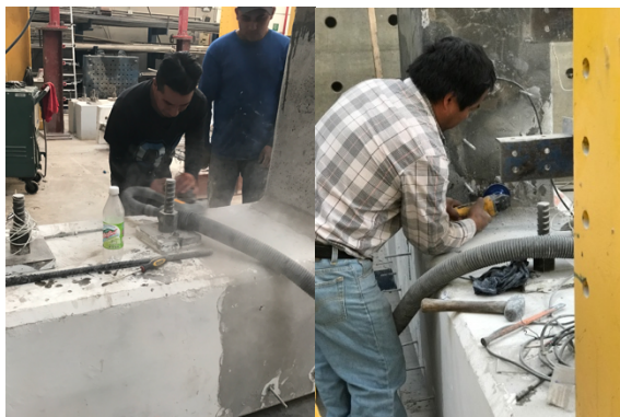
c) Se esmeriló el concreto, con la finalidad de dejarlo poroso y tener un mejor agarre con el sistema PRFC
