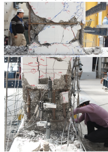
Figura 4.13. Acero expuesto y pandeado, fin de la prueba
