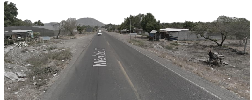
Imagen 41. Imagen de carretera Lázaro Cardenas
