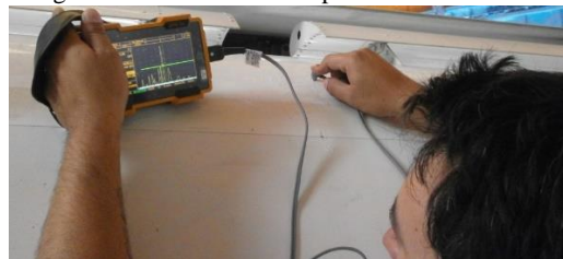
Figura 1.3 - Medición de espesor con ultrasonido.
