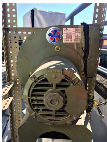
Figura 3.3: Ventilador de jaula de ardilla CFD-7
