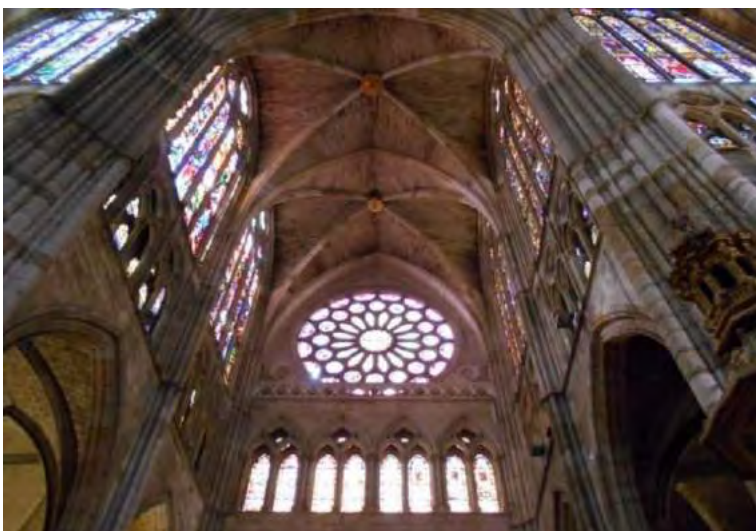
Imagen 22 Detalle del triforio y alzado del brazo sur al interior de la catedral María Fernanda López Narváez, 2017
