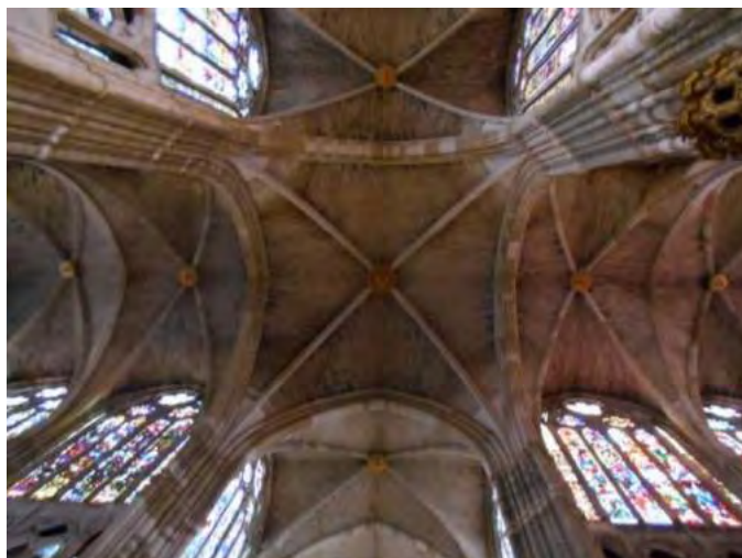
Imagen 15 Bóveda en el área del crucero y del transepto. Obra ejecutada por Demetrio de los Ríos María Fernanda López Narváez, 2017
