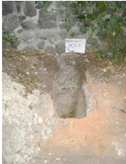
FIGURA 13. POZO A CIELO ABIERTO 6
