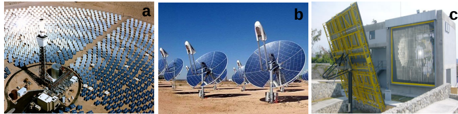
Figura 1.6: Tecnologías de concentración solar a alta temperatura: a) Torre central (Reve 2015), b) Disco parabólico (Muñoz 2015) y c) Horno solar (Estrada et al. 2011).
