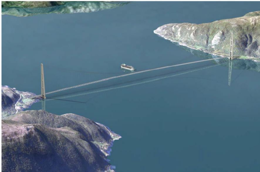
Figura 6.4 Puente Sognejford (Ellevset & Skorpa, 2011)
