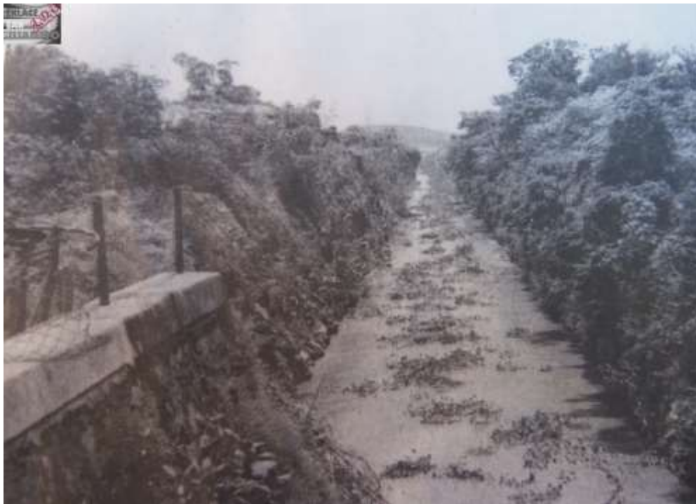
Figura A.10. Canal de captación y desagüe en San Juanito a inicios del siglo XX.
