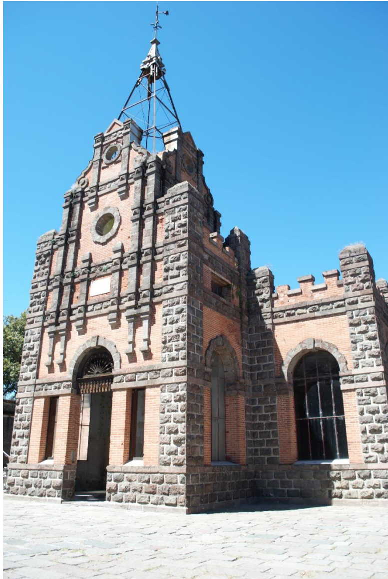
Figura 3.6.- Fotografía exterior del acceso a la planta pasteurizadora.
