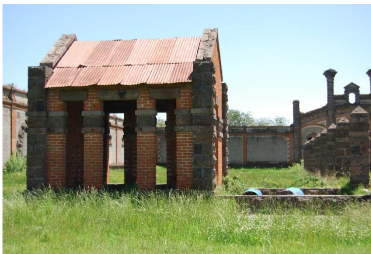
Figura 2.42.- Casetas para bombas
