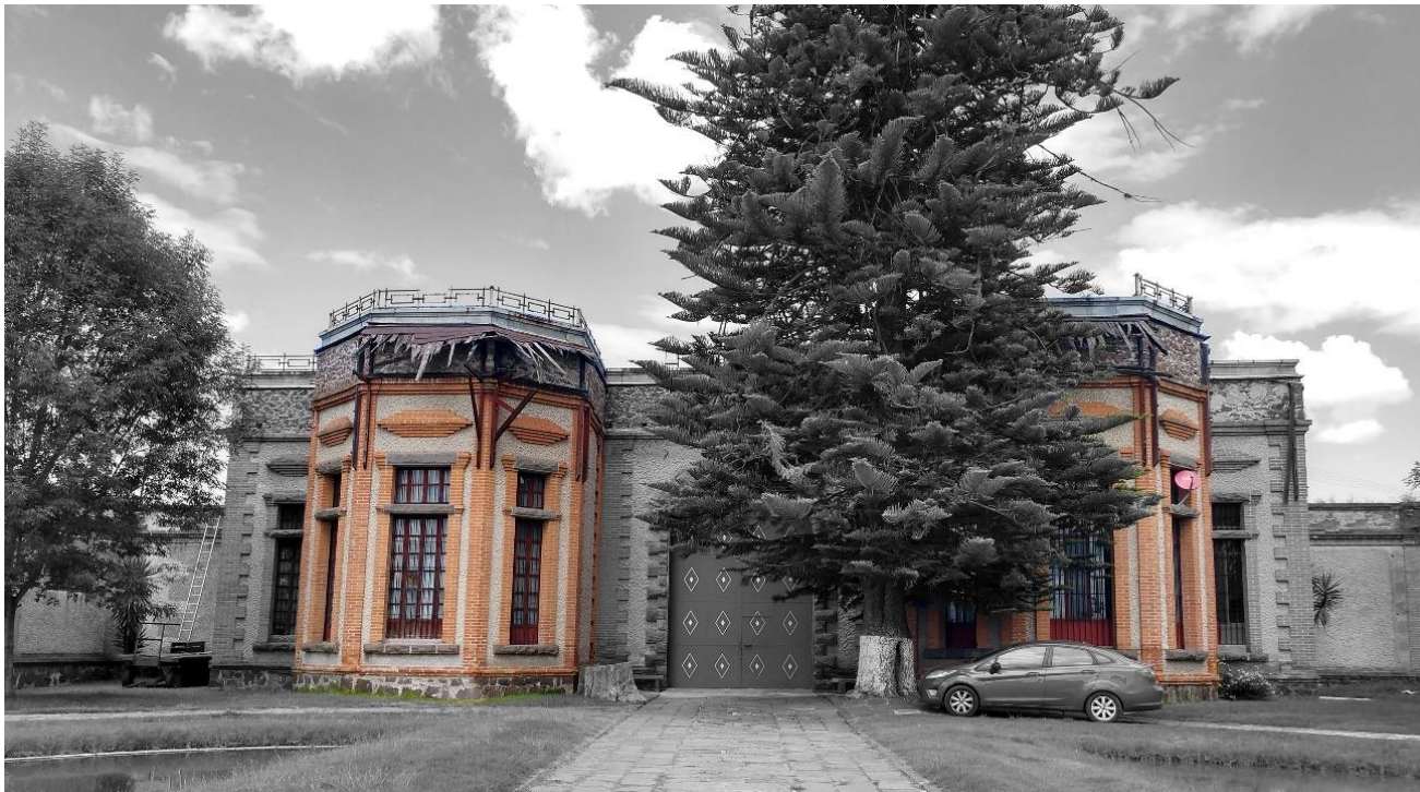
Figura 3.9. Volúmenes poligonales en la fachada principal
