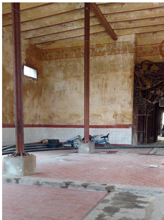
Figura 2.35.- Salón de Pasteurización Fuente: EBL 2016. Este salón se encuentra rodeado por un lambrín de mosaico de pasta color blanco con rojo de la casa S' Henri Marseille. En la imagen aparecen las columnas de hierro que soportan las vigas madres sobre las cuales recae el peso de la losa, permitiendo alcanzar mayores claros que con vigas de madera.
