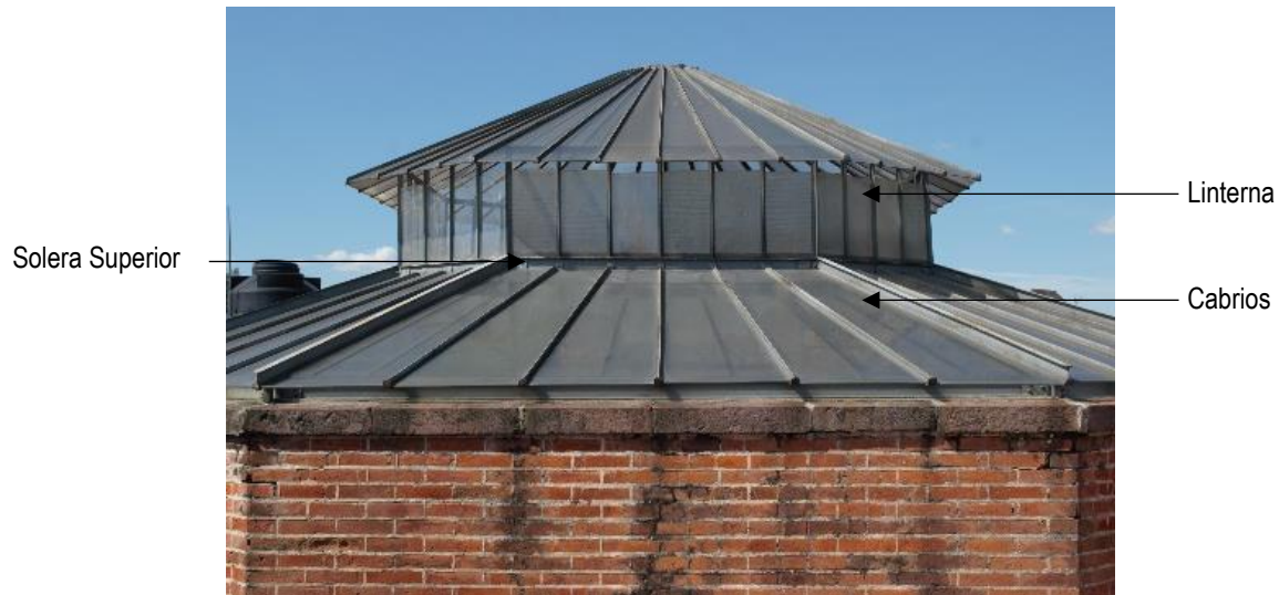
Figura 3.17.- Domo del vestíbulo central Fuente: EBL 2017. Fotografía del domo del hall tomado desde la azotea. En la fotografía se indican algunos de sus componentes.
