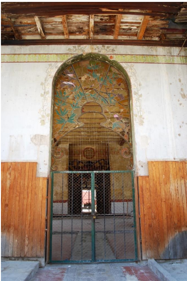
Figura 3.30.- Fotografía de emplomado de amanecer ubicado en el acceso principal a la pasteurizadora. Fuente: EBL 2017.
