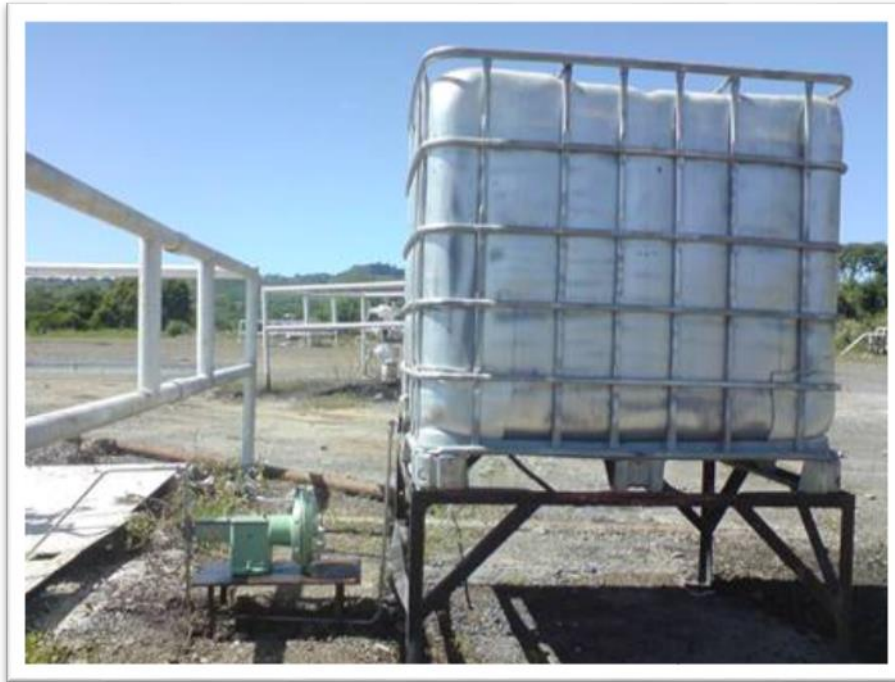
Foto 5.4. Sistema de inyección de productos químicos instalado en pozos, que incluye tanque de almacenamiento y bomba neumática.
