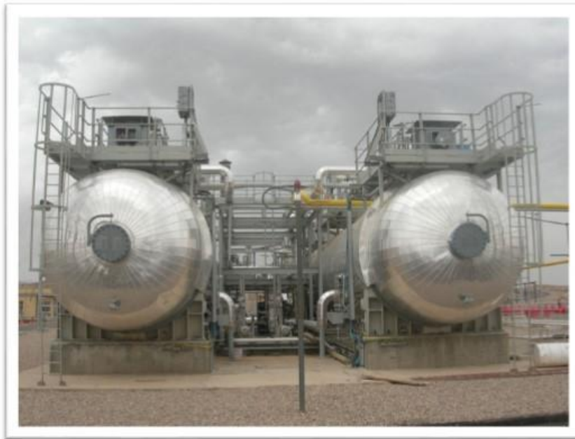
Foto 6.4. Desaladoras electrostáticas industriales.
