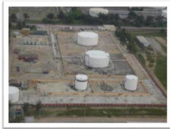
Foto 5.2. Batería de Separación Arenque.
