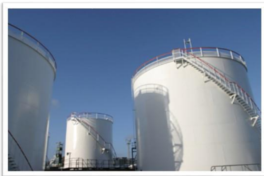
Foto 6.10. Tanques de almacenamiento de crudo para su envío a baterías de separación.
