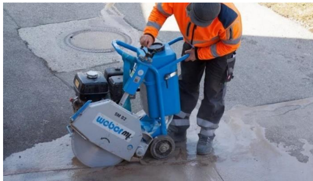
Imagen 7-15. Ranuradora de concreto. 100
