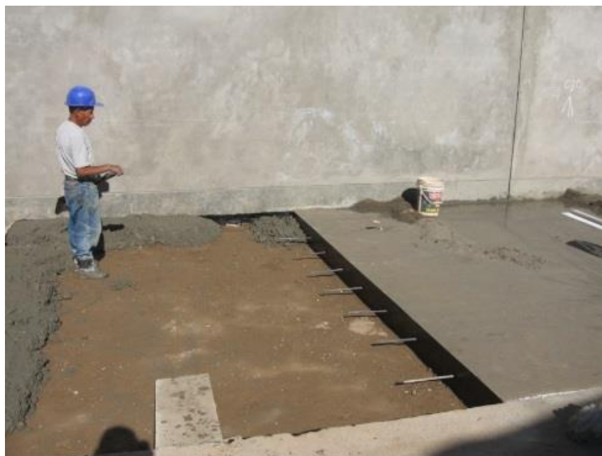
Imagen 9-1. Junta de construcción en pavimentos. 105
