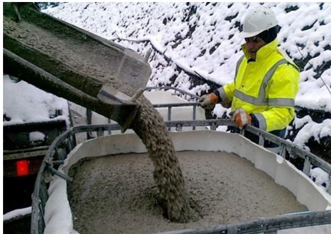
Imagen 1-1. Mezcla de concreto hidráulico. 1
