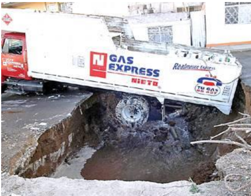
Los servicios se ven interrumpidos a causa del agrietamiento pudiendo causar otro tipo de riesgo.
