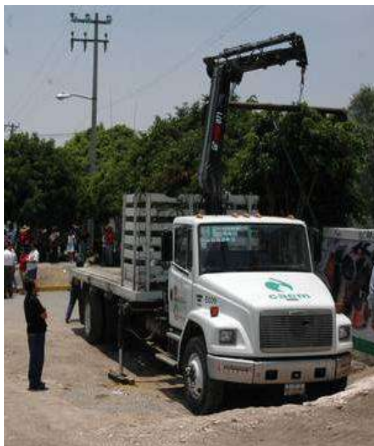
Imagen 11 Instalación de luminarias (Núñez Lopez, 2009)
