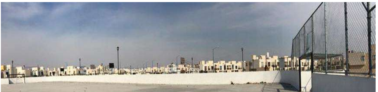
Imagen 41 Foto panorámica fraccionamiento de Ecatepec (Elaboración Propia, 2018)
