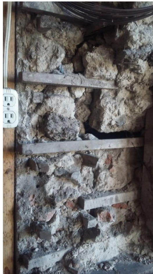
Imagen 6 y 7. Muros de Bahareque en el área de servicio del objeto de estudio. Tomada por Jéssica Gavidia en Enero 2017
