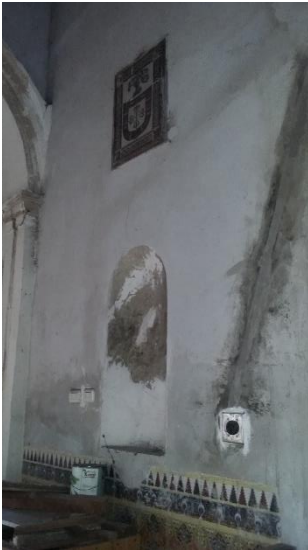
Imagen 37. Instalaciones eléctricas agregadas recientemente en muros de tabique del vestíbulo. Tomada por Jéssica Gavidia en Julio 2016.
