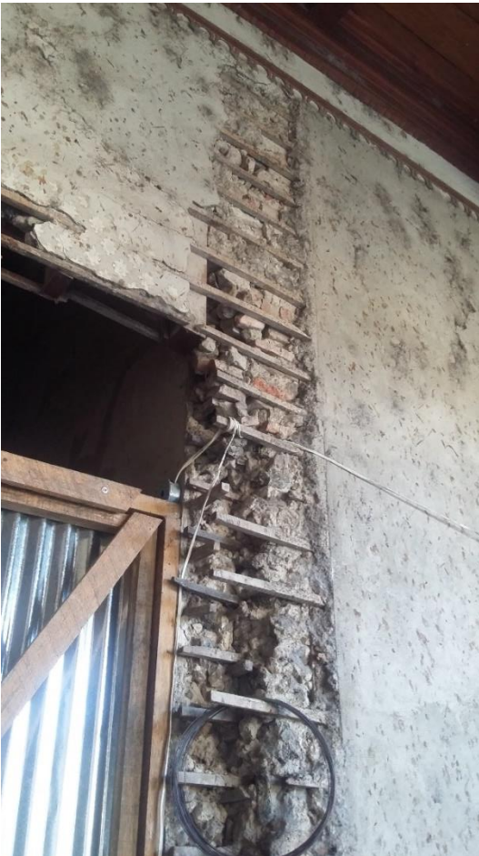
Imagen 6 y 7. Muros de Bahareque en el área de servicio del objeto de estudio. Tomada por Jéssica Gavidia en Enero 2017
