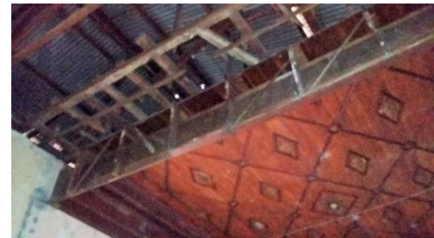
Imagen 8. Estructura de madera que sostiene los plafones de las diferentes habitaciones del objeto de estudio. Tomada por Jéssica Gavidia en Enero 2017
