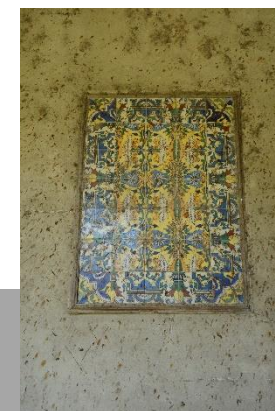
Imagen 36. Daños provocados por la fauna en el interior del inmueble. Tomada por Jéssica Gavidia en Julio 2016.
