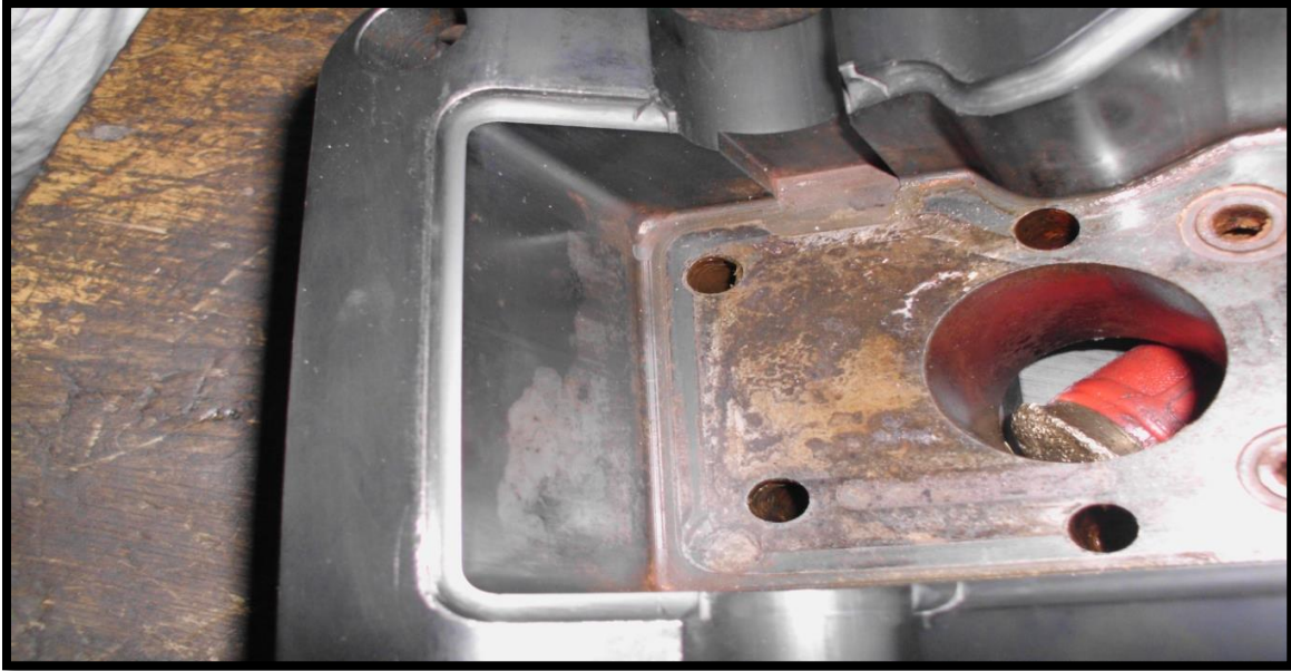
Fig. 76, oxidación en arillo de alojamiento para o-ring.
