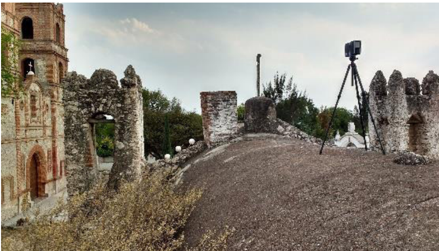
Imagen 20. Escáner láser en la cubierta de una capilla. Se observan las referencias esféricas utilizadas para unir la bóveda con el resto del modelo.
