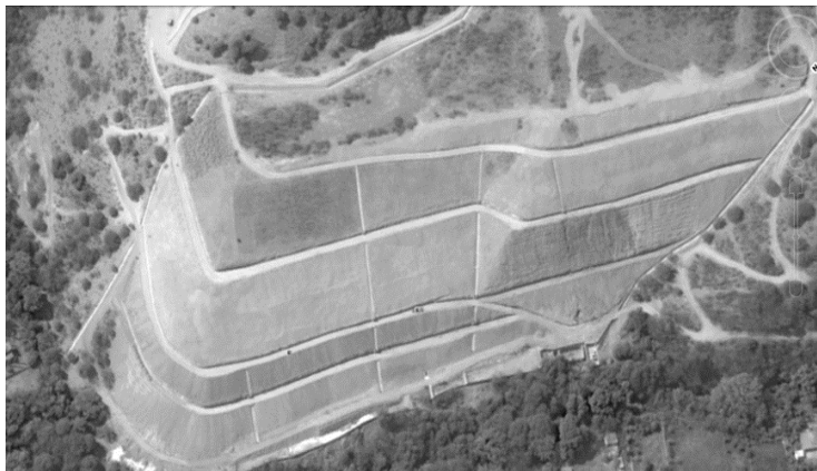
Figura 1. Presa de Jales inactiva.
