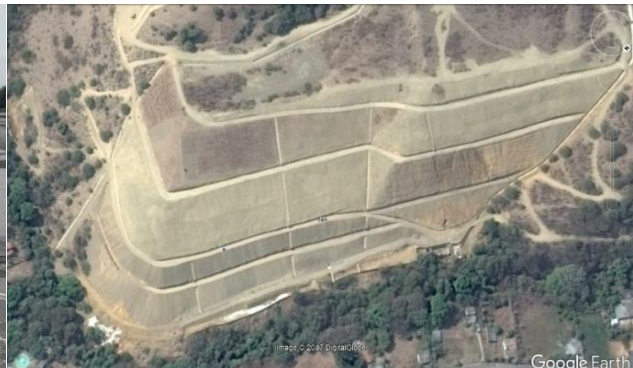
Figura 1.2 Presa de jales vista aérea, 2015.
