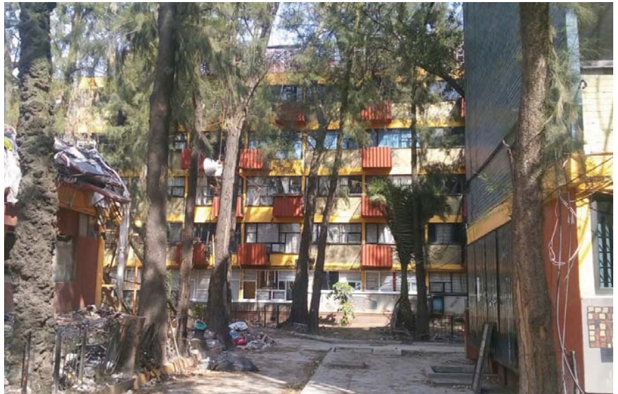
Imagen 32. Vista de los espacios exteriores.
