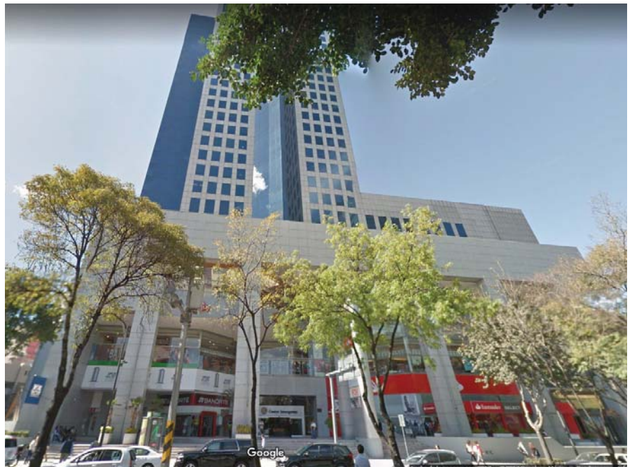
Imagen 21. Vista de la Torre Mural que denota la diferencia del espacio de la torre al área comercial. Google.com
