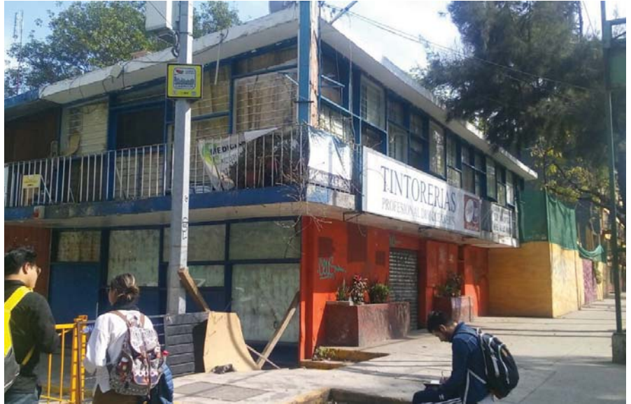
Imagen 31. Vista del deterioro del espacio comercial
