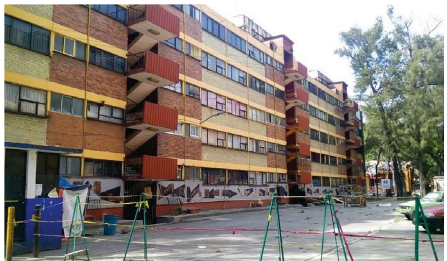
Imagen 28. Viviendas desalojadas del Edificio 4B
