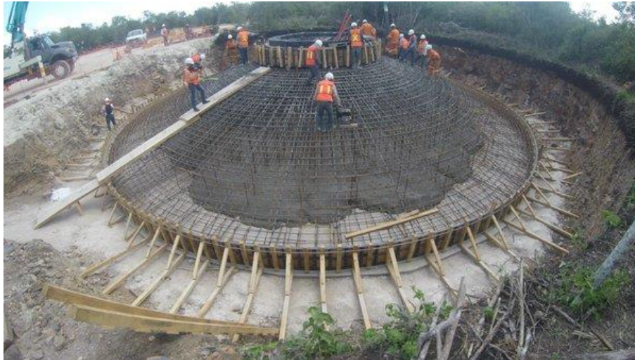
Figura 9.2: Cimentación de un aerogenerador del parque eólico “Tres Mesas”, Llera, Tamaulipas. Fuente: Comisión de Energía de Tamaulipas, 2015.
