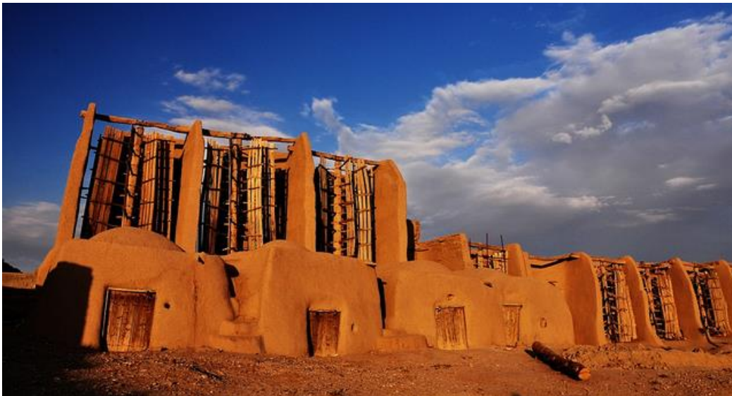
Figura 9.0: Molinos de viento de eje vertical construidos entre el año 500 y 900 D.C., Nashtifan, Irán. Fuente: Mohamad Reza Shahpasand, 2012.
