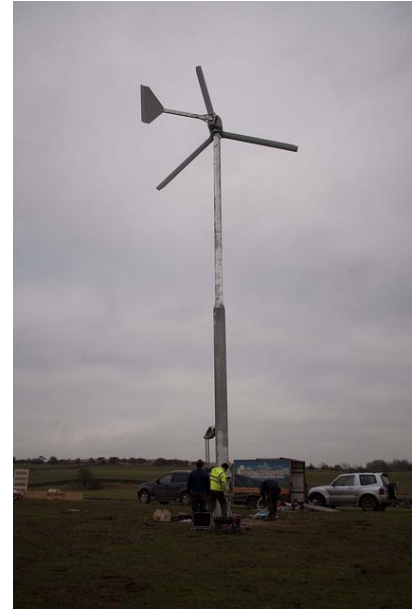
Figura 10.1: Instalación de un aerogenerador de 10 kW para abastecer una granja, Inglaterra. Fuente: Charles McGowan, 2012.
