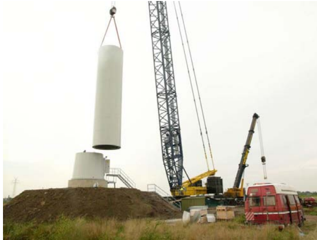
Figura 9.3: Instalación de una torre para un aerogenerador en el parque eólico “Bremerhaven”, Bremerhaven, Bremen, Alemania. Fuente: Hannes Grobe, 2007.
