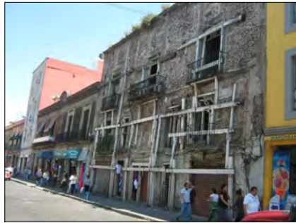
Foto No. 45.- Fachada estado actual
