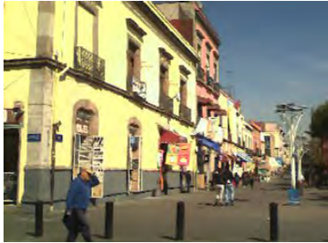
Foto No. 8. VII. Esquina de calle Alhóndiga con Corregidora (Ruiz, 2016).
