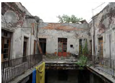
Foto No. 38. (2). Vista ala Este. Tiene barandal de hierro forjado en todo el perímetro del pasillo, de igual manera un faldón de lámina. Cuenta con puertas de madera, metal y cortinas metálicas, muros de tezontle y tabique rojo recocido (Ruiz, 2016).
