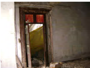
Foto No. 39. (3). Interior ala norte. Las puertas que intercomunican los espacios cerrados son de madera y cuentan con antepecho, marcos de madera y derrame (Ruiz, 2016).
