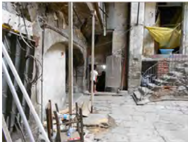
Foto No. 27. (5). Vista de acceso principal, semisótano y primer piso. El acceso principal cuenta con un arco rebajado, el acceso a semisótano se encuentra por debajo del nivel del patio, y el acceso al 1º piso es por medio de unas escales
