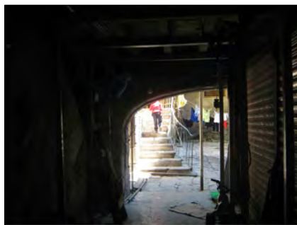
Foto No. 46.- Acceso estado actual
