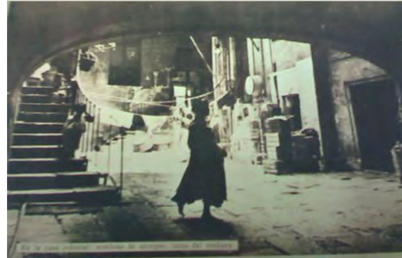
Foto No. 1 Foto obtenida del Proyecto de Restauración por el Arq. Vicente Flores A. (Flores, 1986)
