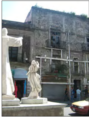
Foto No. 44.- Fachada estado actual
