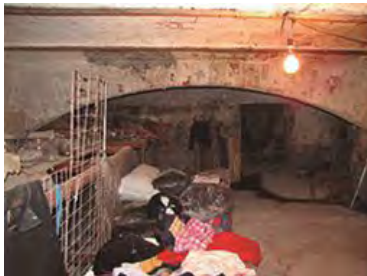
Foto No. 26. (4). Semisótano. Los muros son de tezontle y piedra braza, con un espesor de hasta 90 cm, entrepiso de viguería de acero y bóveda de ladrillo y arcos rebajado. Originalmente debieron usarse como bodega (Ruiz, 2016)
