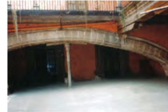
Foto No.17.- Patio principal cubierto por una losa de concreto. (Cantro,s.f.)
