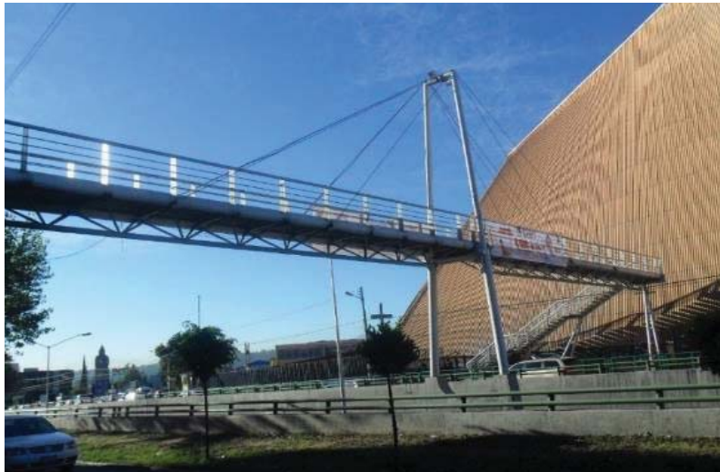
Figura 1.6 Puente atirantado en Av. Lomas Verdes, Naucalpan
