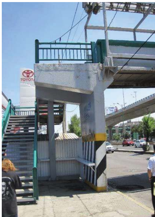
a) Vista de la columna donde se recargan las escaleras de acceso
