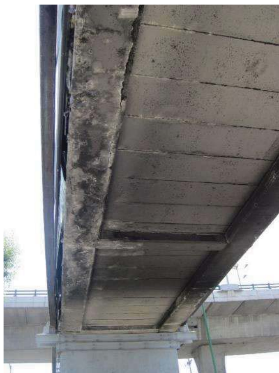
b) Vista de la sección inferior de la viga de paso
