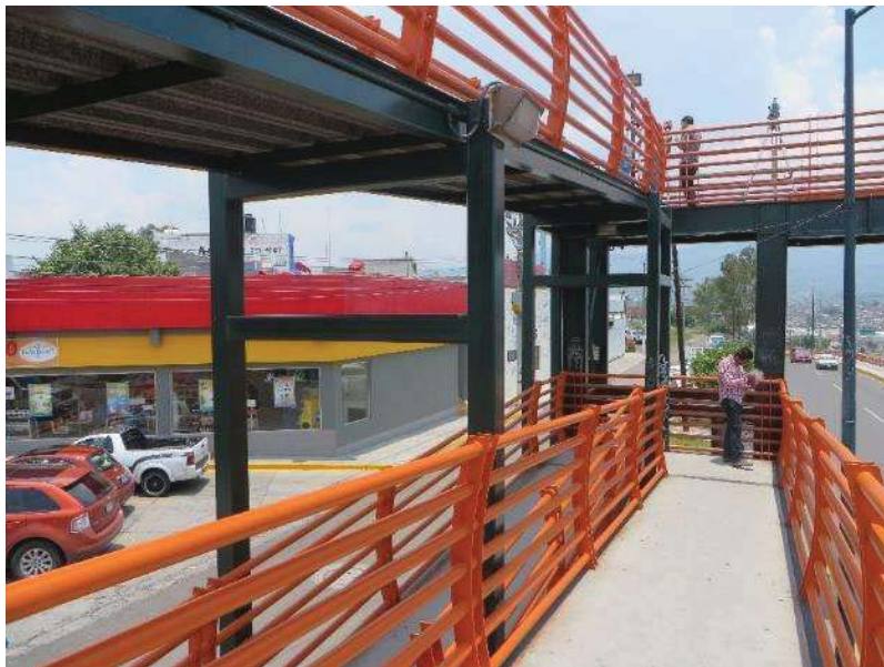
Figura 13.2 Vista de las rampas de acceso
