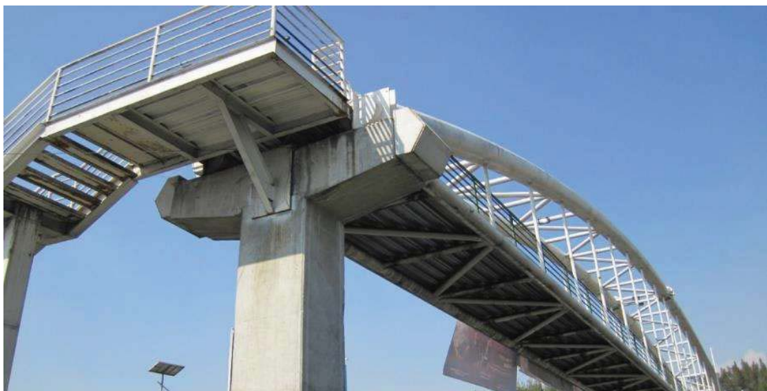
Figura 8.3 Vista inferior del puente Satélite
