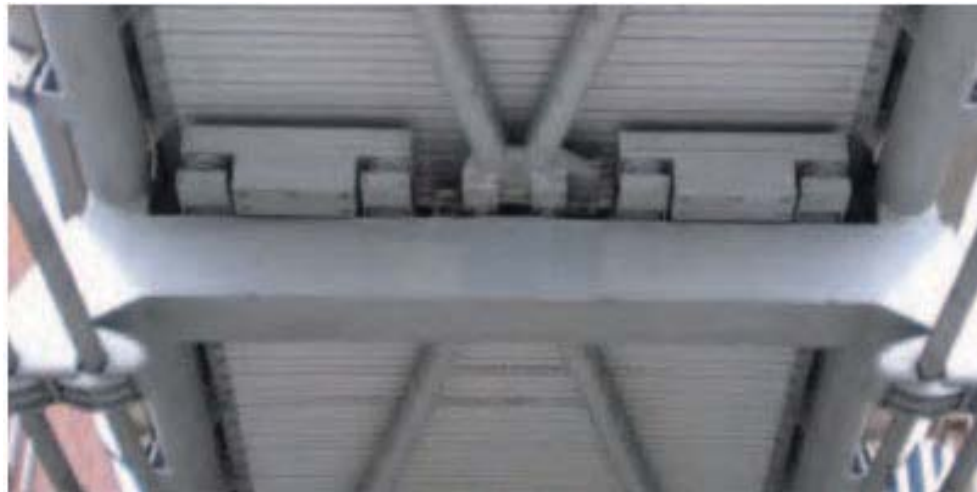
b) Amortiguadores de masa sintonizados
