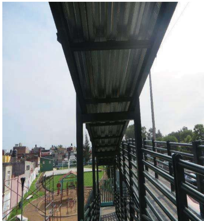
Figura 12.2 Vista de los marcos donde se apoyan las rampas de acceso
