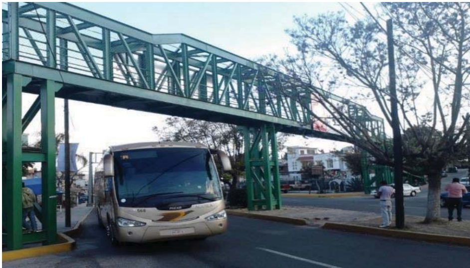
a) Puente metálico en Ixtapan de la Sal
