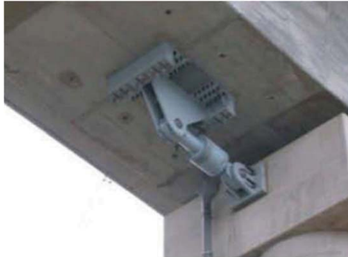
Figura 5.2 Amortiguador de choque
