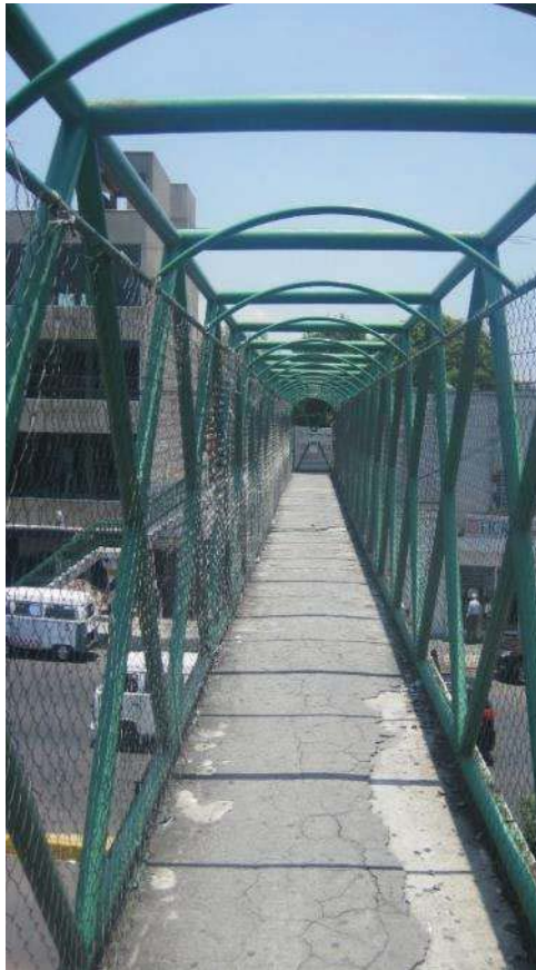
a) Vista superior de la viga
