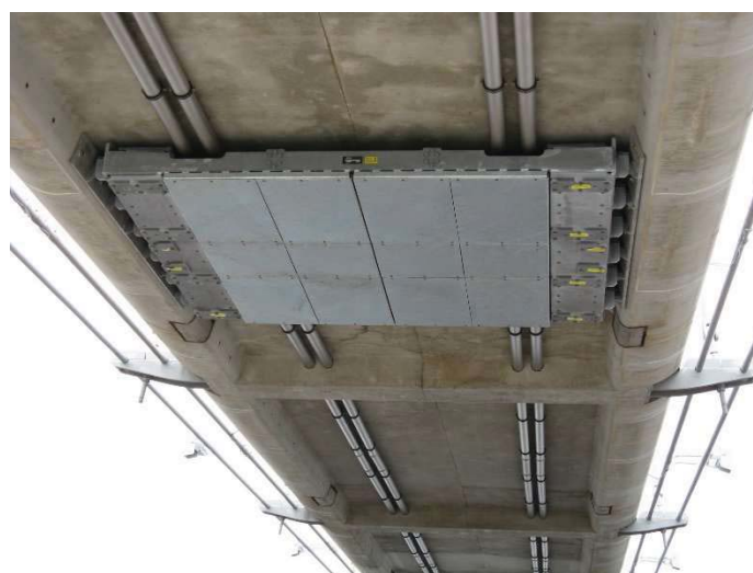
Figura 5.1 Amortiguador de masa sintonizada o TMD
