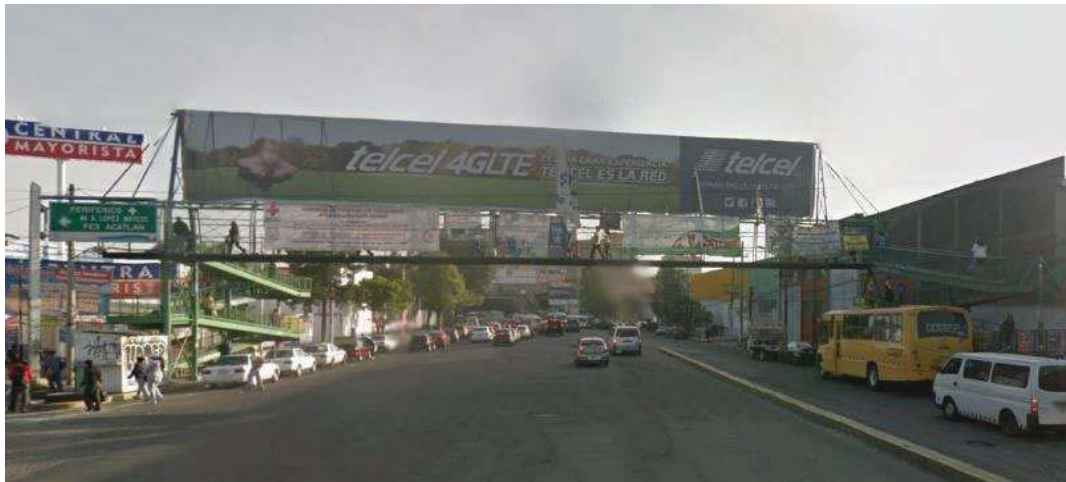
Figura 7.2 Vista frontal del puente San Bartolo
