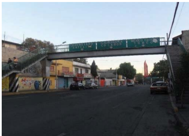
a) Puente de concreto con viga doble T
