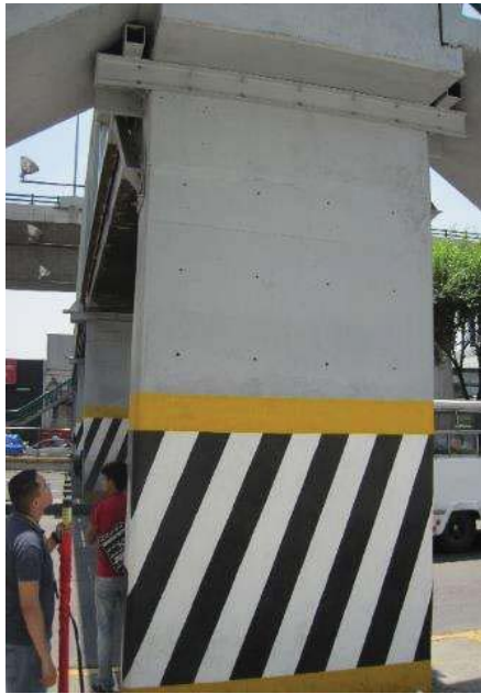
a) Vista de la columna de concreto del lado de la baqueta de San Bartolo II
