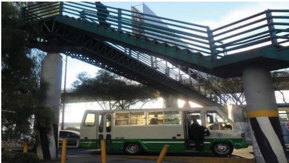
b) Puente metálico con sistema de tridilosa en Tlalnepantla de Baz
