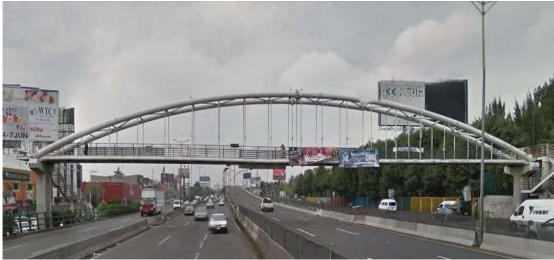
Figura 8.2 Vista frontal del puente Satélite
