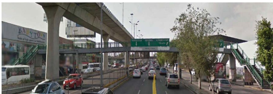
b) Vista frontal del puente San Bartolo II Figura 11.1 Puente San Bartolo II
