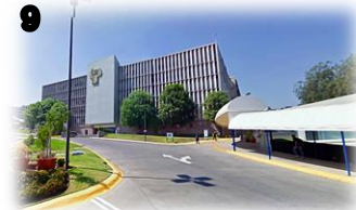
9 UNITEC, POSEE 5 NIVELES DE ALTURA (17 M APROX.) ESTRUCTURA DE ACERO Y CONCRETO. ALEJAMIENTO DEL EDIFICIO DE LA VIA PUBLICA.
