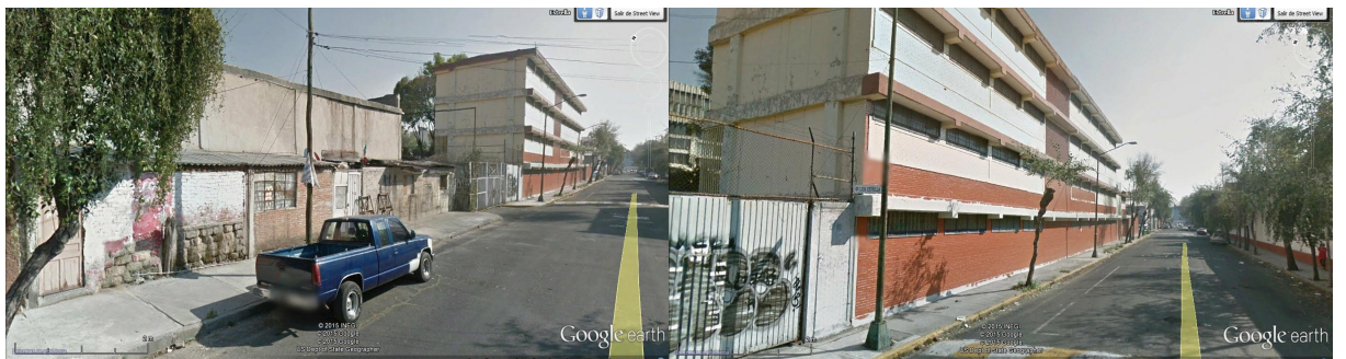
Vista D. Fachadas Vecinas Actuales. Calle Estrella. Fuente. Google Earth
