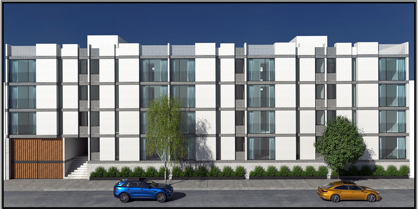
Fachada Principal. Calle Estrella
