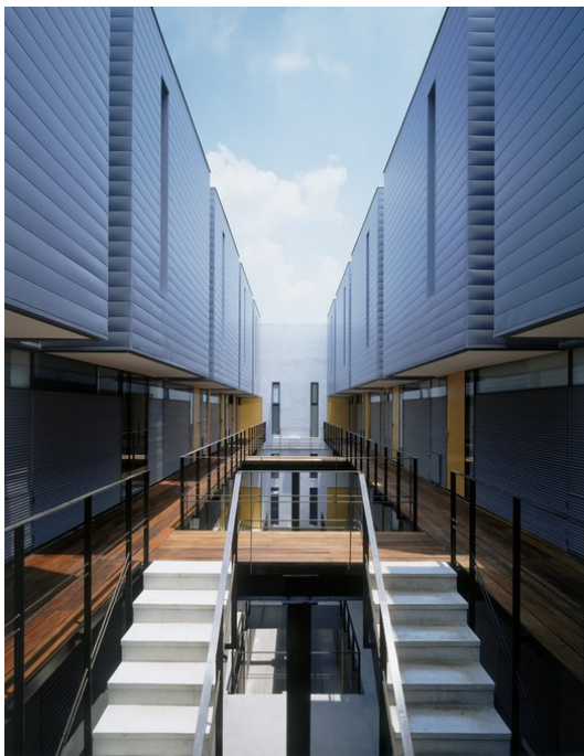
Patio Interior. Proyecto: 13 de Septiembre
