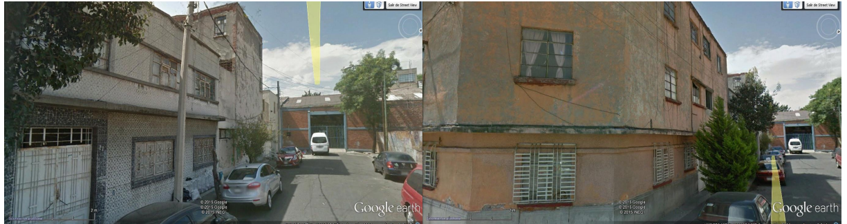
Vista C. Fachadas Vecinas Actuales. Calle Sirio.
