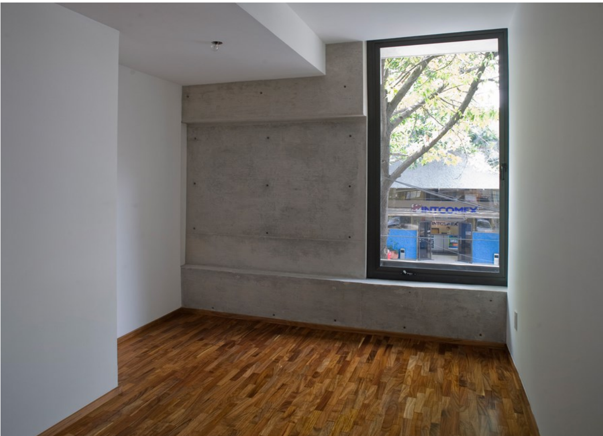
Concreto Aparente y Ventilación Natural. Proyecto: Prosperidad 31. Fuente. Javier Sánchez Arquitectos
