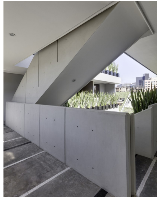
Uso de Concreto Aparente. Proyecto: TK 139
