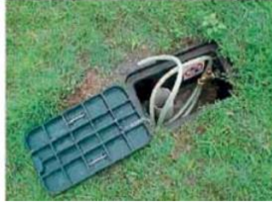
Figura 17. Muestreo manual de agua residual en una tubería a presión. Fuente: Foley et al. (2009).
