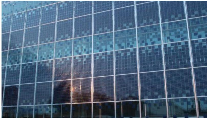
Ilustración 6. Ejemplo de muro cortina. Fuente: <http://www.archiexpo.es>
