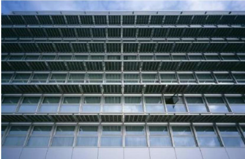
Ilustración 8. Ejemplo de parasoles fotovoltaicos. Fuente: <https://inarquia.es/>
