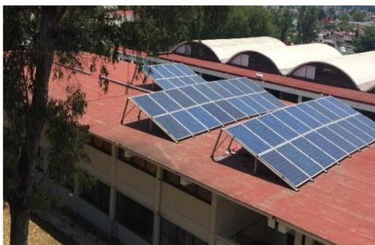
Ilustración 15. Planta Fotovoltaica de 10 kW del Posgrado de Ingeniería. Elaboración propia.
