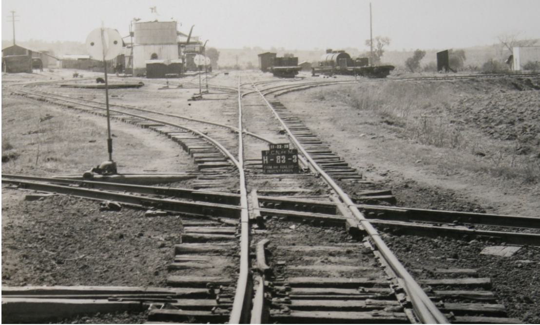
Imagen 4. Patio de vías de la estación del ferrocarril Tapa en Hidalgo en el año de 1926. El pie de foto original señala que es el cruzamiento de la vía Decauville de la hacienda de Tapa, productora de pulque. Fondo Comisión de Avalúo e Inventario. Fototeca del Centro de Documentación e Investigación Ferroviaria, Secretaría de Cultura de México.
