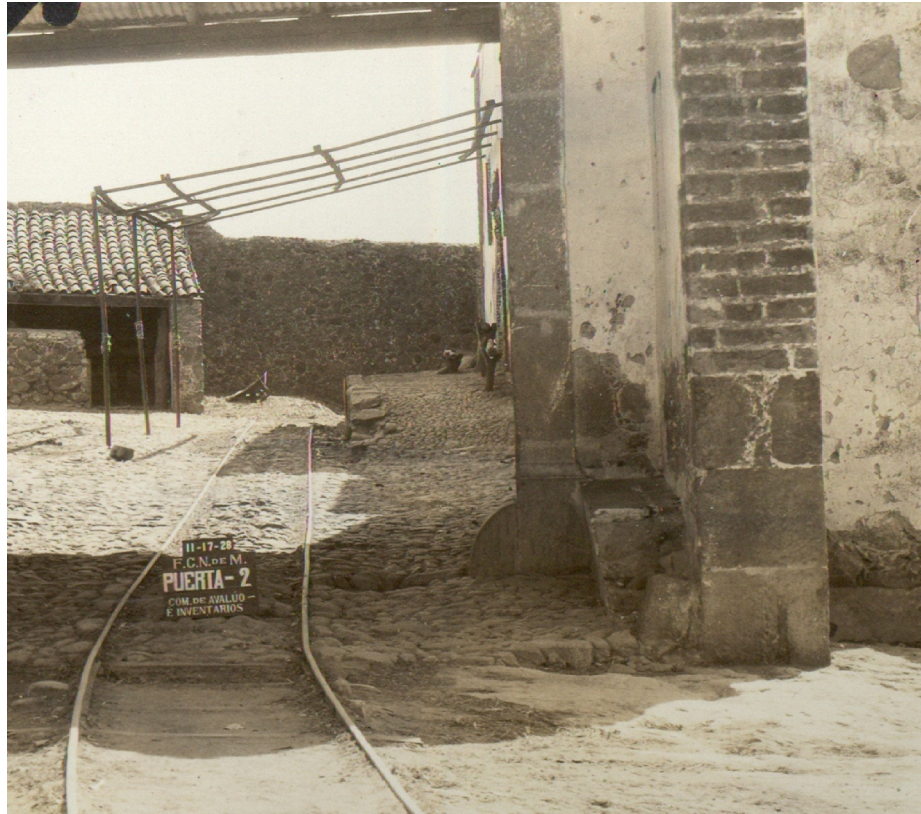
Imagen 5. Acercamiento de una vía Decauville al interior de una hacienda en el año de 1926. Al fondo se observa el muelle de carga. La bodega debió estar continua a este. Fondo Comisión de Avalúo e Inventario. Fototeca del Centro de Documentación e Investigación Ferroviaria, Secretaría de Cultura de México.
