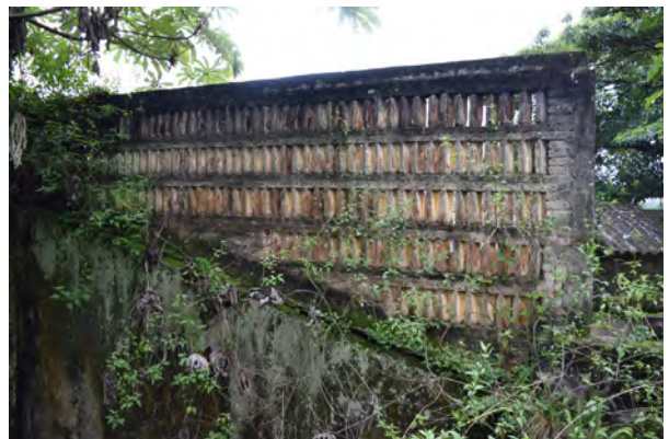
Figura 38 Imagen del uso del ladrillo en la fábrica de hilados y tejidos La Purísima
