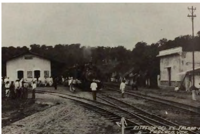
Figura 13 Estación de ferrocarril en Teocelo (García Morales, 1984)
