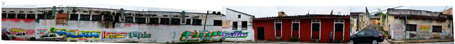
Figura 43 Larguillo fotográfico del estado actual de la fachada de la antigua fábrica de hilados y tejidos La Purísima
