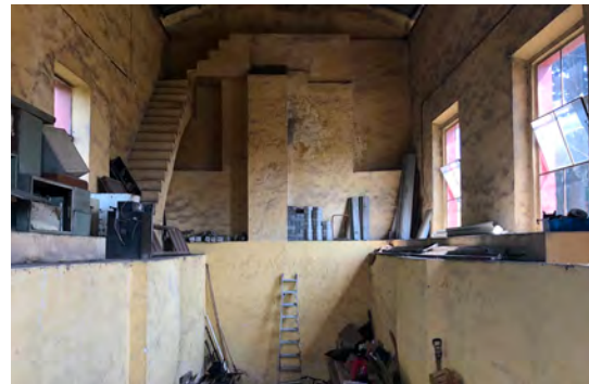
Figura 24 Interior del edificio donde solía estar la turbina hidráulica que generaba la energía en la antigua fábrica de hilados y tejidos de Lucas Martín
