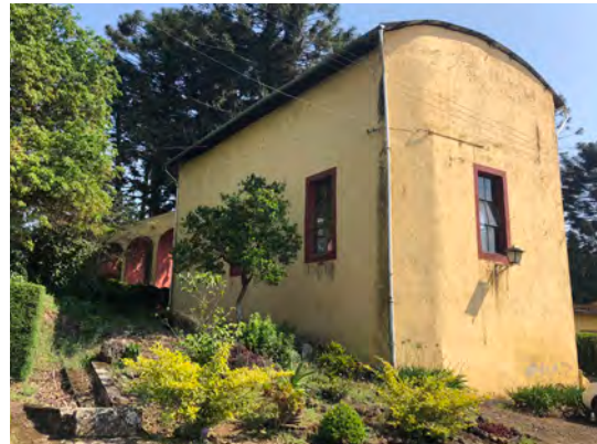
Figura 23 Edificio donde desemboca el acueducto de la hacienda Lucas Martín y donde se encontraba la turbina hidráulica
