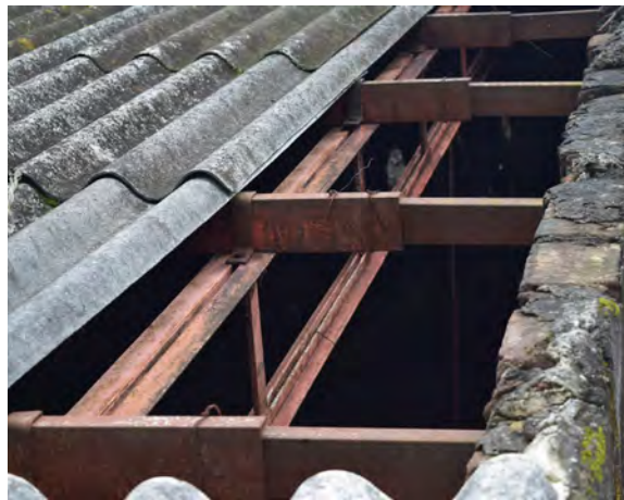
Figura 41 Imagen de uno de los sistemas de cubierta dentro de la fábrica de hilados y tejidos La Purísima
