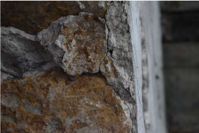
Figura 35 Muro de mampostería compuesta que constituye la fábrica La Purísima
