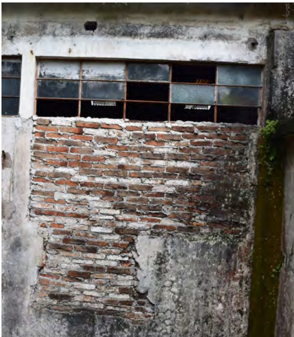
Figura 36 Imagen de uno de los muros de ladrillo de la fábrica de hilados y tejidos La Purísima
