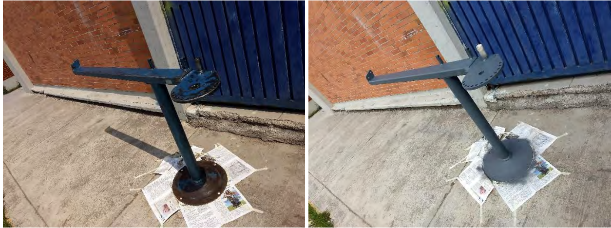
Figura 5.16 Aplicación de primer gris a dobladora de tubos.
