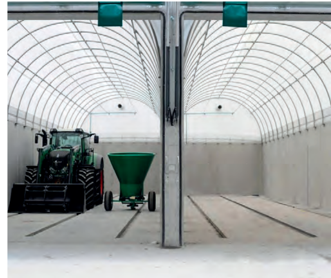
[Fig. 79] interior de Túnel de concreto armado.
