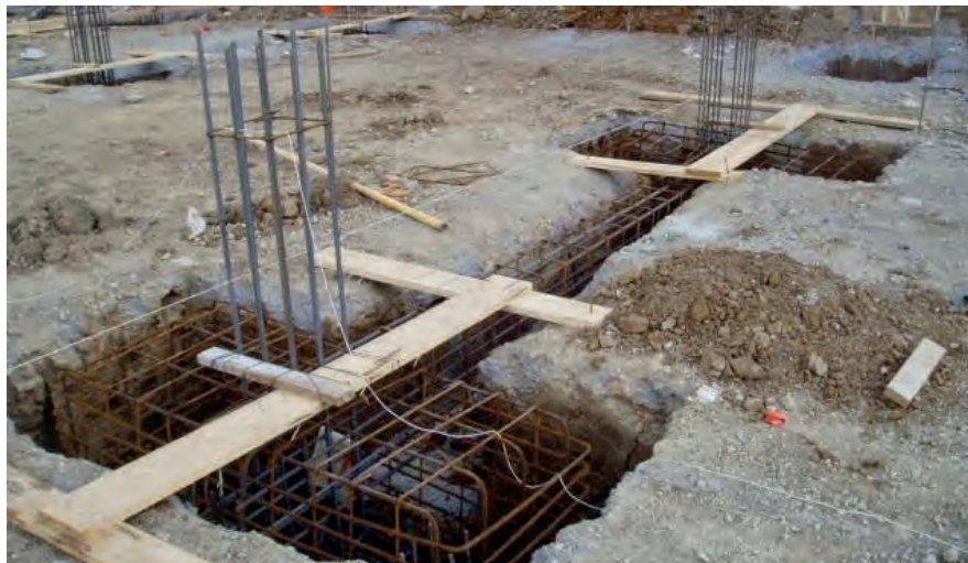
[Fig. 143] Preparación de zapata aislada de concreto armado.
