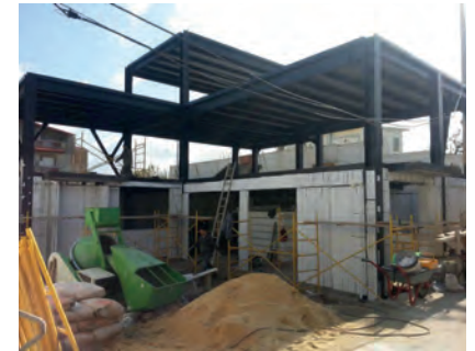
[Fig. 131] Estructura de acero en negro mate.
