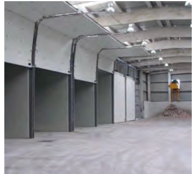
[Fig. 80] Exterior de Túnel de concreto armado.
