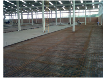
[Fig. 127] Piso de concreto armado pulido.
