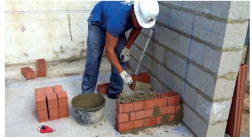
[Fig. 125] Muro de bock de cemento arena.
