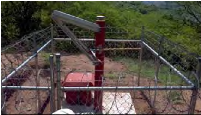
Figura 1-11. Estación y componentes GPS del monitoreo en la C.H La Yesca Fuente: Fotos propias.
