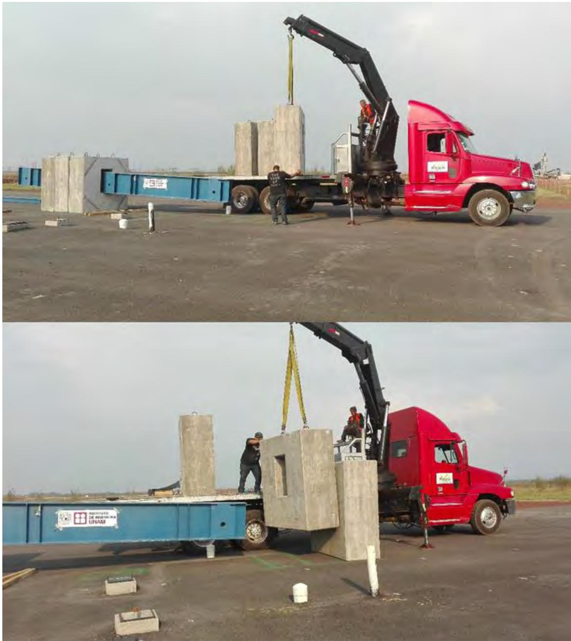
Figura 3.25 Maniobras con grúa tipo hiab de los bloques de concreto y viga de acero.
