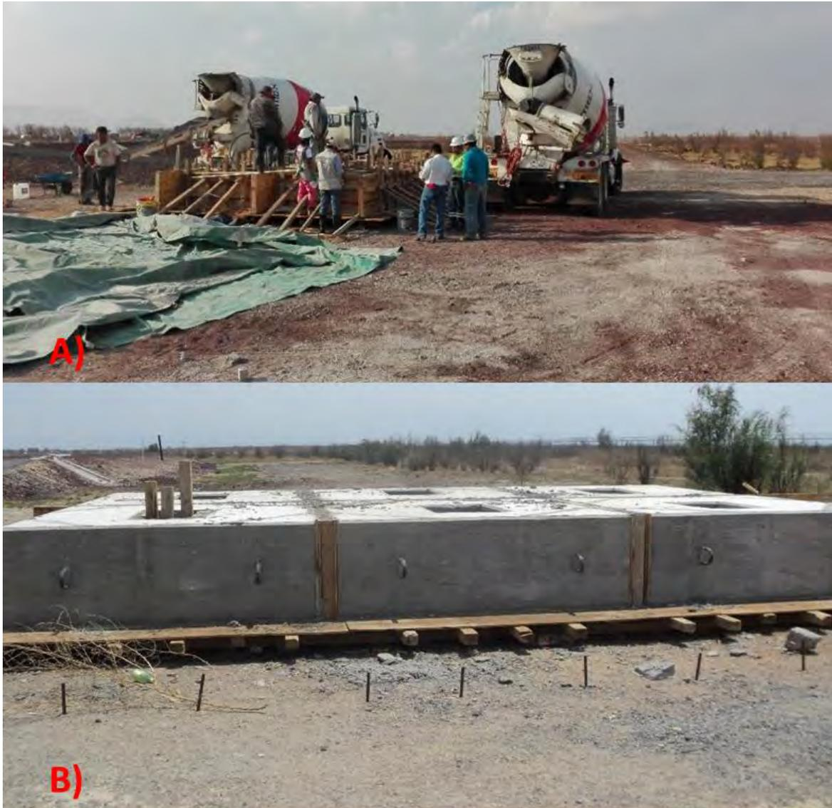
Figura 3.24 Colado y fraguado de los bloques de concreto.
