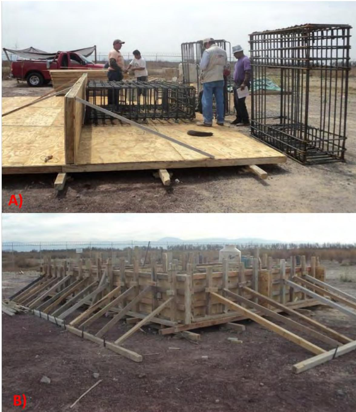
Figura 3.23 A) Realización del armado, B) Habilitado de la cimbra para colado en sitio.
