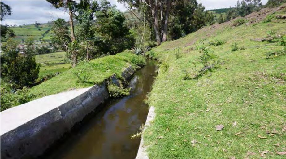
**Figura 61.** Acequia Pumamaqui recubierta de hormigón (Fotografía del autor)
