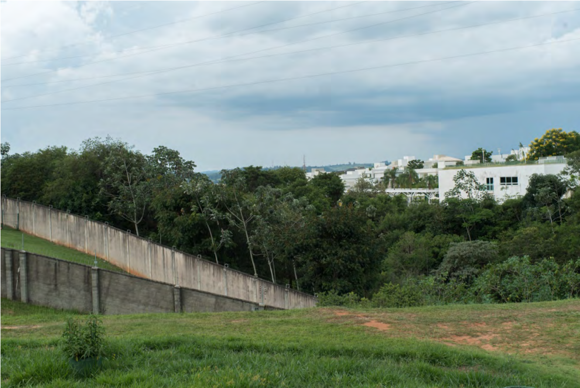
Img 3. El muro que separa el barrio privado de Jardim de Araucárias , Sousa, Campinas. Foto tomada en enero 2016.
