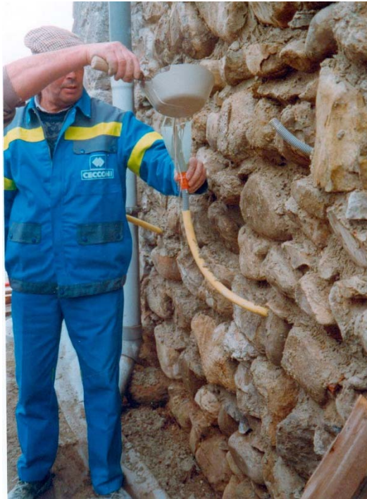
Fig. 3.1. Aplicación por gravedad de una inyección de mortero (Ciment & architecture, 2018)
