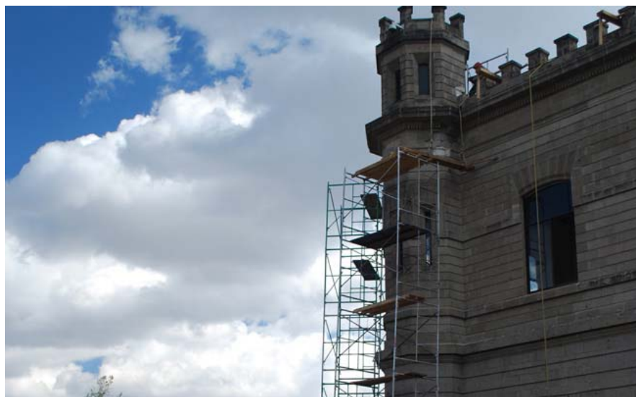
Fig. 2.10. Trabajos de manteniendo en la cantera de la fachada (AGN, 2010)
