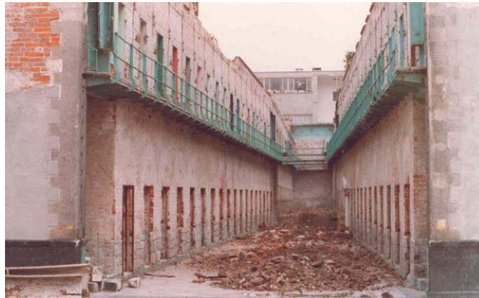
a) Durante la remodelación
