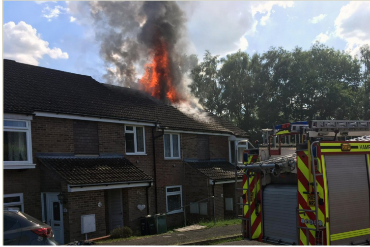
Figura 4. Incendio en el techo de una casa ocasionado por una falla de tipo arco eléctrico en el SFV instalado. Por Daily Echo, 2018. Retomado de https://www.dailyecho.co.uk/news/16269478.warning-about-solar-panels-after-fire-in-wellbrooke-gardens/ . Copyright [2018] Gannett Company.
