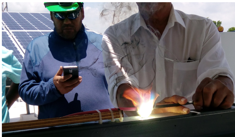
Figura 43. Arco eléctrico generado intencionalmente en un SFV.
