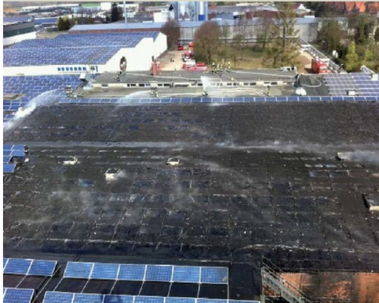
Figura 8. Secuelas del incendio en un almacén de Goch, Alemania; ocasionado por un arco en el SFV. En “Ready for the new standard?” , por Michael Breuer, 2017, Monitor: Magazin for electrical sefty. Retomado de www.bender.de/monitor-abo . Copyright [2018] Bender GmbH Co.
