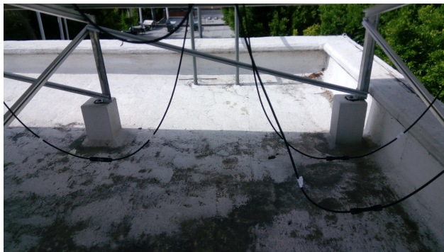
Figura 79. Diferencia de altura entre las mojoneras debido al desnivel en el techo.
