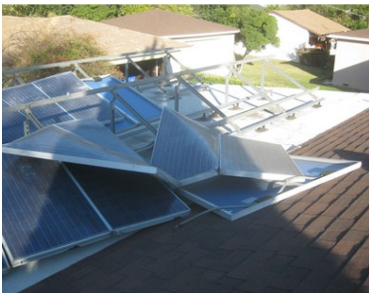
Figura 2. SFV arrasado por la acción del viento mostrando un mal cálculo en el anclaje de los mismos. Por Jim Jenal, 2012. Recuperado de https://runonsun.com/runons5/blogs/blog1.php/solworks/safety/ros-2-windstorm-zero . Copyright [2014] Run On Sun.
