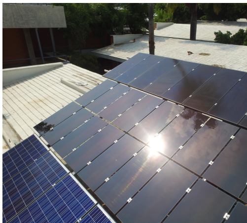
Figura 76. Reflejo producido por un módulo de telurio cadmio en el IER el 10 de julio a las 4:26 PM.
