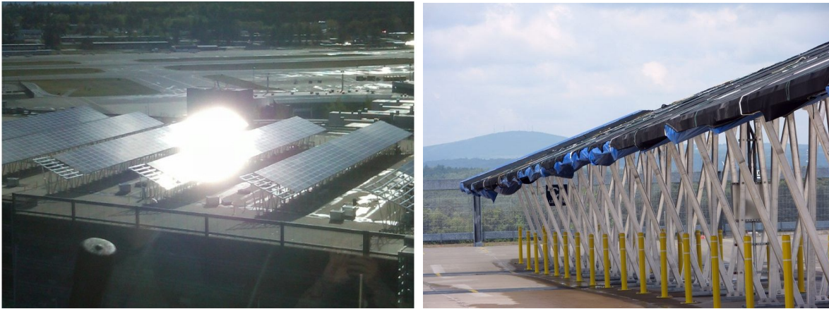
Figura 16. Resplandor visto desde la Torre de Control de Tráfico Aéreo en el Aeropuerto Regional de Manchester/Boston (8:15 AM EDT, 27/04/12) y módulos cubiertos como solución al problema. En “Manchester airport remains in dark over solar-panel glare solution” , por Mark Hayward, 2013. Copyright 2018 Union Leader Corporation.
