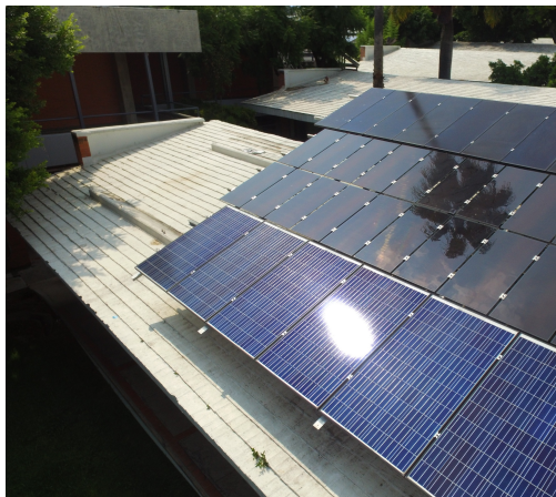
Figura 75. Reflejo producido por un módulo de silicio policristalino en el IER el 10 de julio a las 4:26 PM.
