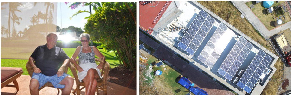
Figura 15. De izquierda a derecha: planta fotovoltaica afectando una zona residencial cercana (The Molokai News, Octubre 21, 2013, 3:55 pm) (16) y reflejo de luz en módulos instalados en el IER (Marzo 22, 2018, 10:54).
