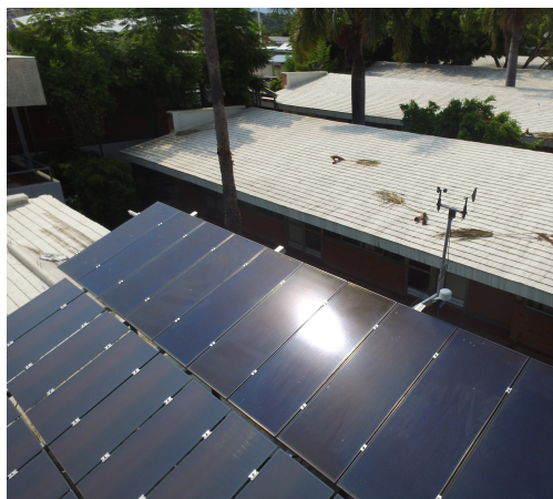
Figura 77. Reflejo producido por un módulo de película delgada en el IER el 10 de julio a las 4:27 PM.
