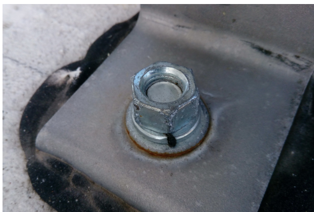
Figura 82. Tuerca sin lograr cubrir la el tornillo.
