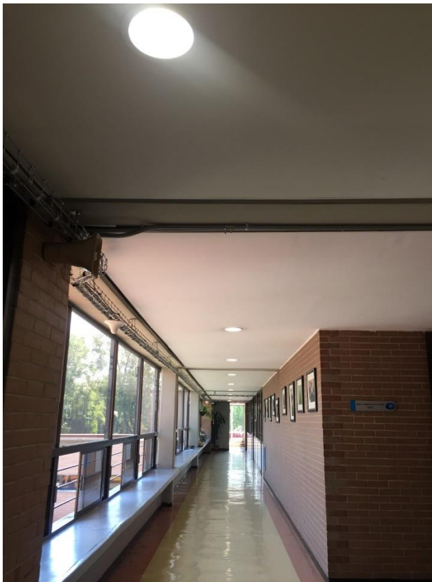
Fotografía. 10. Casita de las ciencias. Pasillo Planta Baja Oficinas
