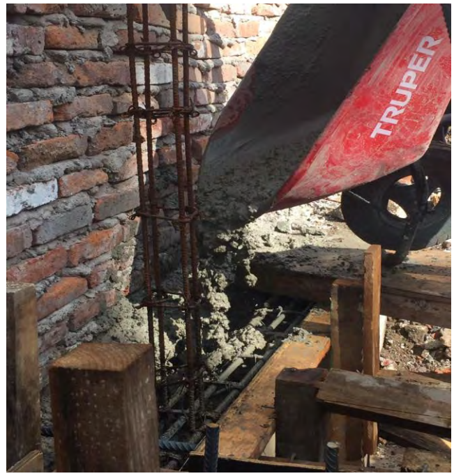
Imágenes 63 y 64: Armado inicial de las zapatas y colado en sitio...
