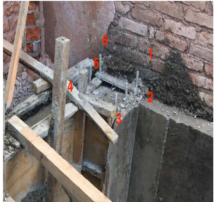
Imagen 63: Varillas listas para recibir placa de asiento
