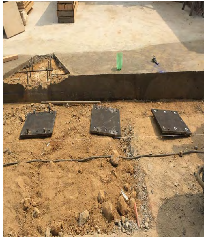
Imágenes 69 y 70: Enrazado de firme cuerpo B, anclaje de castillos y delimitación de área para placas de asiento y placas de
