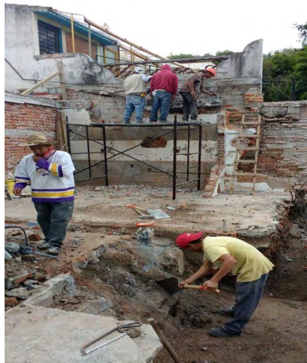
Imagen 51: Demolición planta baja cuerpo A
