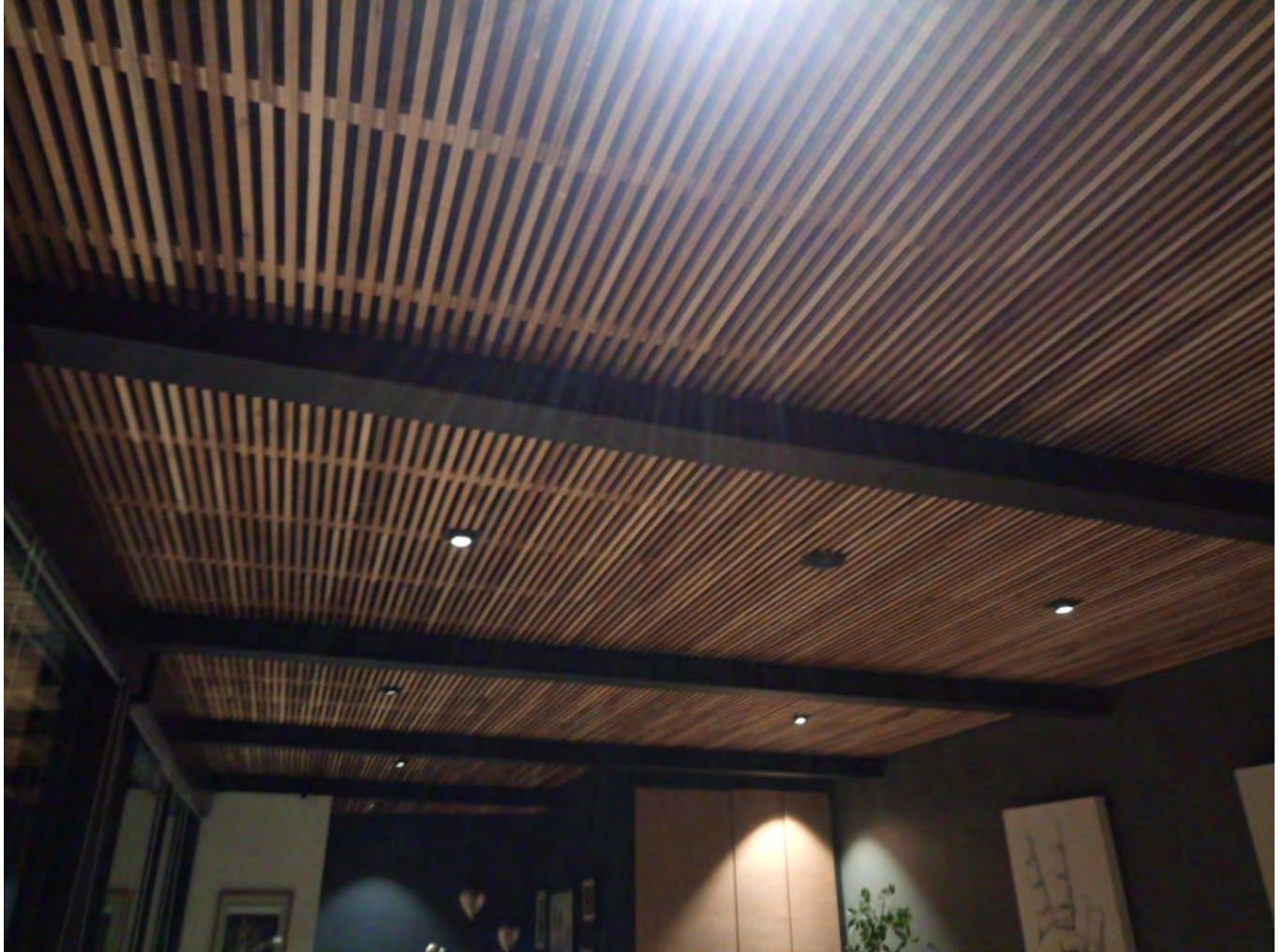
Imágenes 191, 192 y 193: Proceso de instalación y acabado de plafón de marimba.
