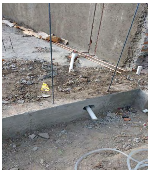
Imágenes 67 y 68: Instalaciones hidrosanitarias en firme de planta baja.
