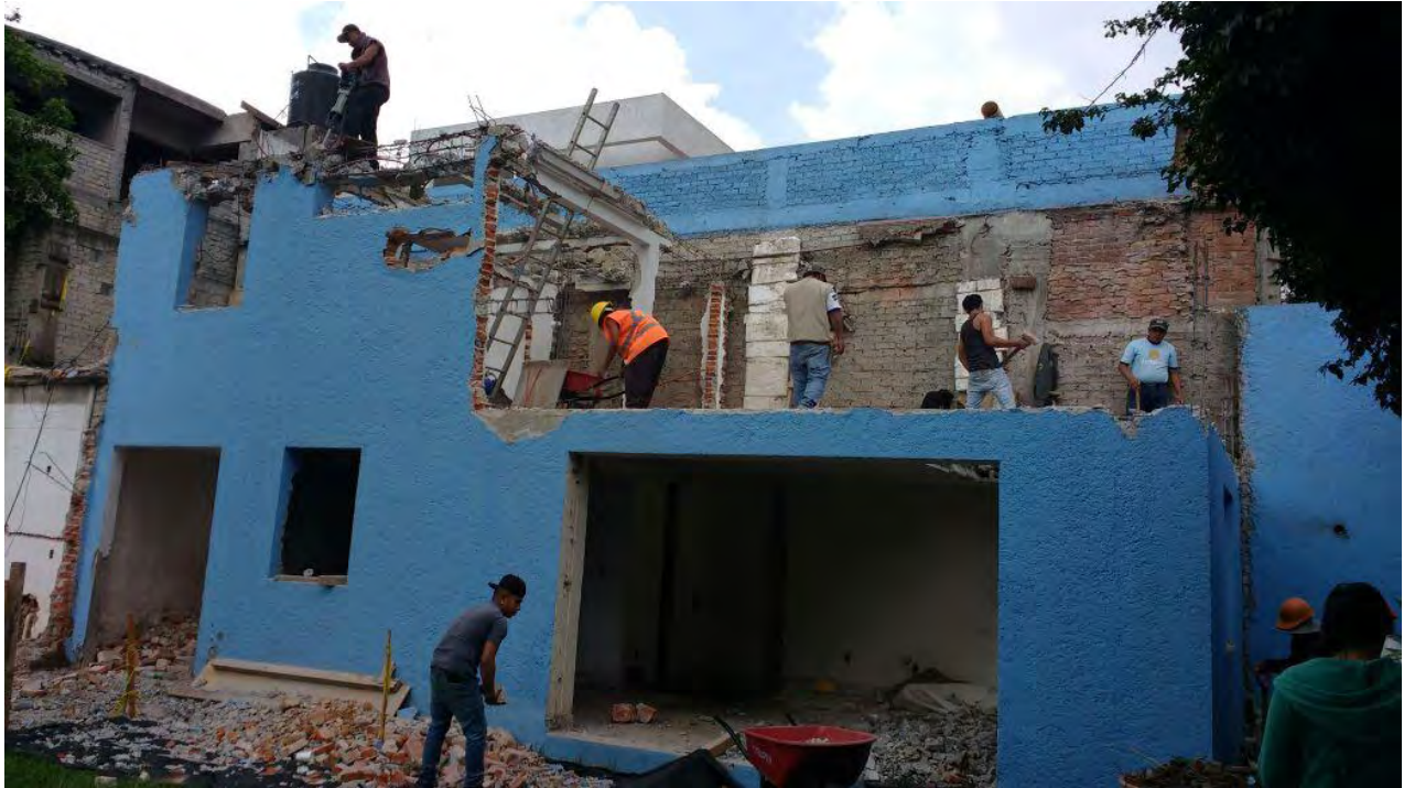
Imagen 48: Demolición de planta alta cuerpo B.
