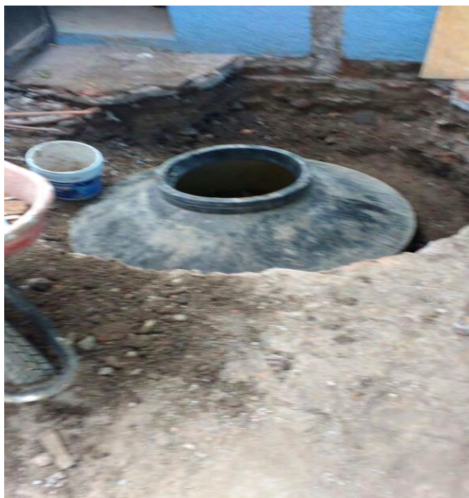
Imagen 52: Desmantelado de cisterna.
