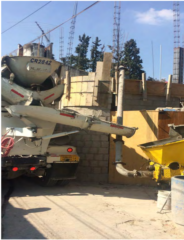
Imágenes 159 y 160: Muros de fachada en el proceso de colado de losa de primer nivel y desplante de muros sobre la cimentación
