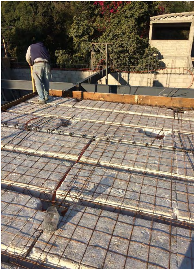
Imágenes 117 y 118: Sistema de vigueta y bovedilla colocado, instalación eléctrica tendida y tragaluz hecho con vigueta y bovedilla.
