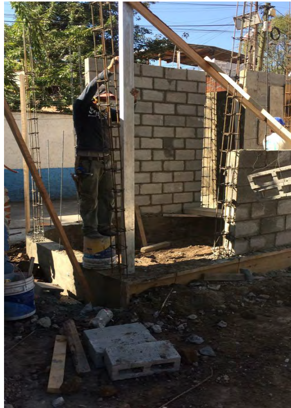
Imágenes 159 y 160: Muros de fachada en el proceso de colado de losa de primer nivel y desplante de muros sobre la cimentación
