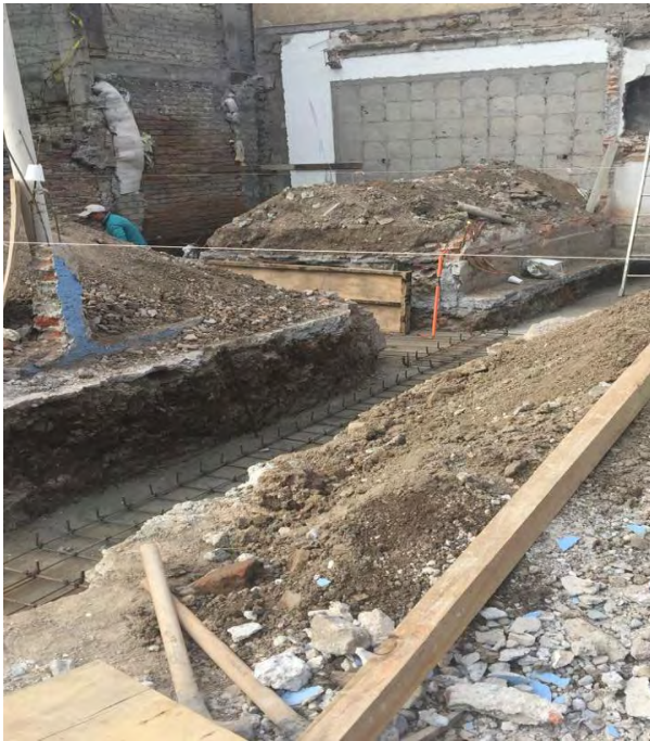
Imágenes 63 y 64: Armado inicial de las zapatas y colado en sitio...
