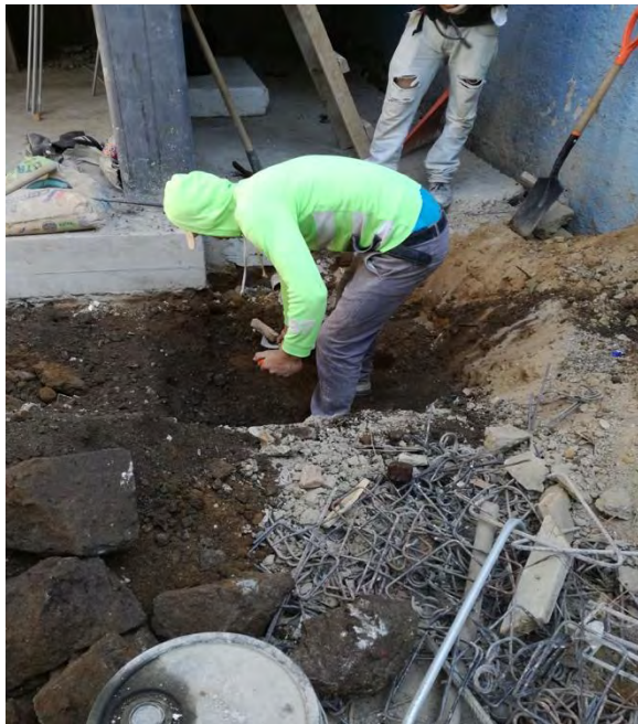
Imágenes 143 y 144: Excavación para registro y tendido de tubería.
