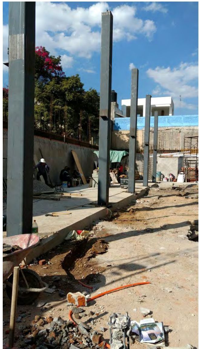
Imagen 81 y 82 : Levantamiento de columnas de acero
