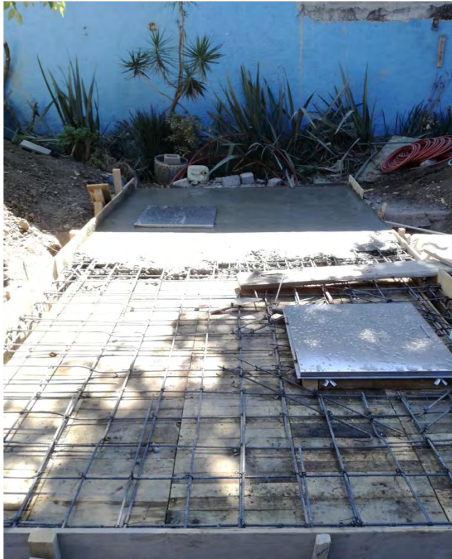
Imágenes 149, 150, 151, 152, 153, 154, 155, 156 y 157: Excavación, armado de muros y castillos, apuntalamiento, armado y de losa de las cisternas
