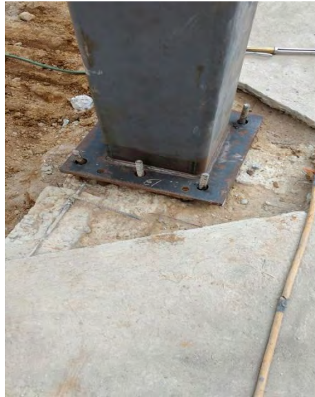
Imagen 83: abotonamiento de columnas.
