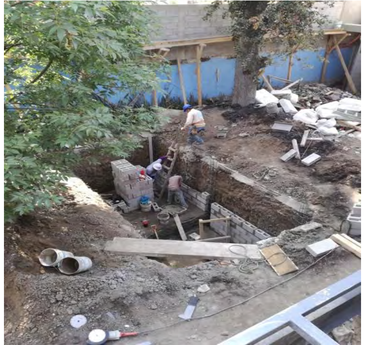
Imágenes 57 y 58: Excavación para las cisternas.
