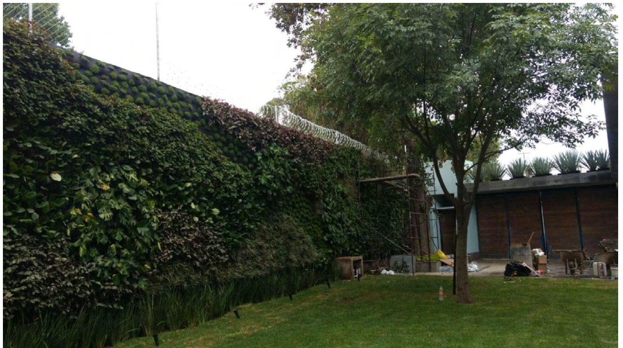
Imágenes 210 y 211: Colocación de plantas y acabado de muro verde.
