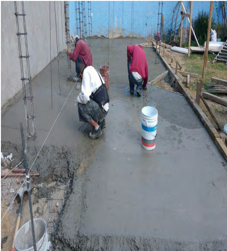
Imágenes 69 y 70: Enrazado de firme cuerpo B, anclaje de castillos y delimitación de área para placas de asiento y placas de
