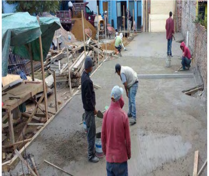
Imagen 72: Enrazado de firme cuerpo A
