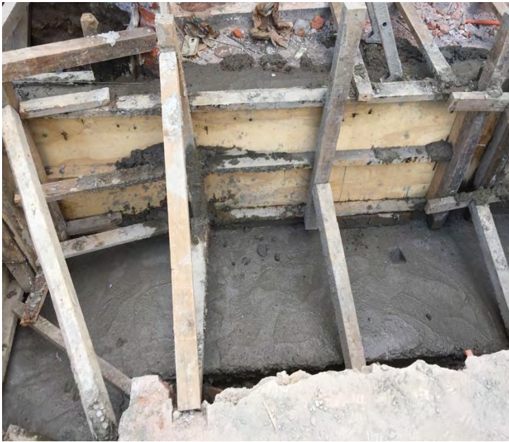
Imagen 62: Encofrado de cimentación y plantilla de concreto pobre.
