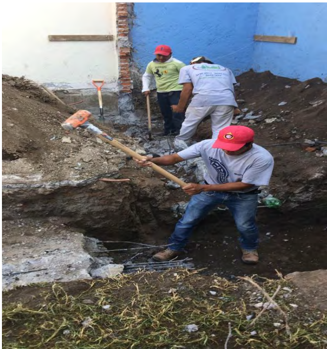
Imagen 50: Demolición de cimentación.
