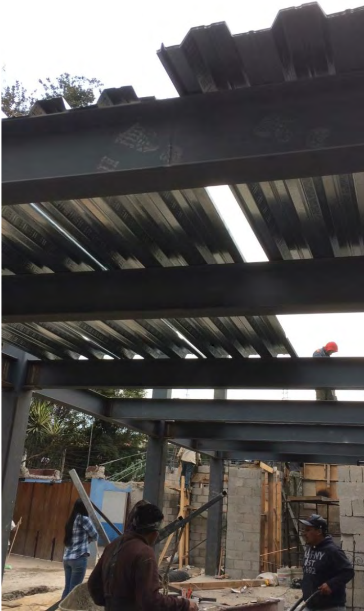
Imágenes 92 y 93: Posición de las láminas de la losacero
