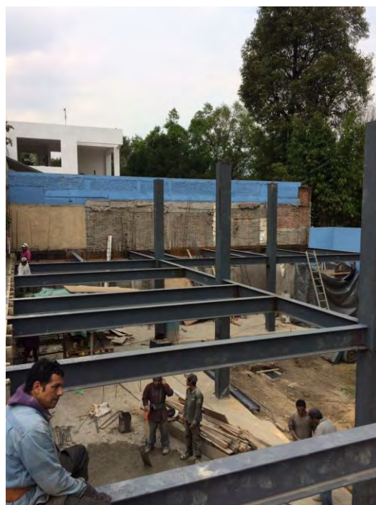
Imágenes 88, 89 y 90: Estructura de acero para primera planta montada
