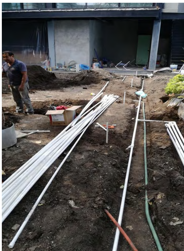
Imágenes 183 y 184: Tendido de tuberías de riego automático y controlador del sistema.
