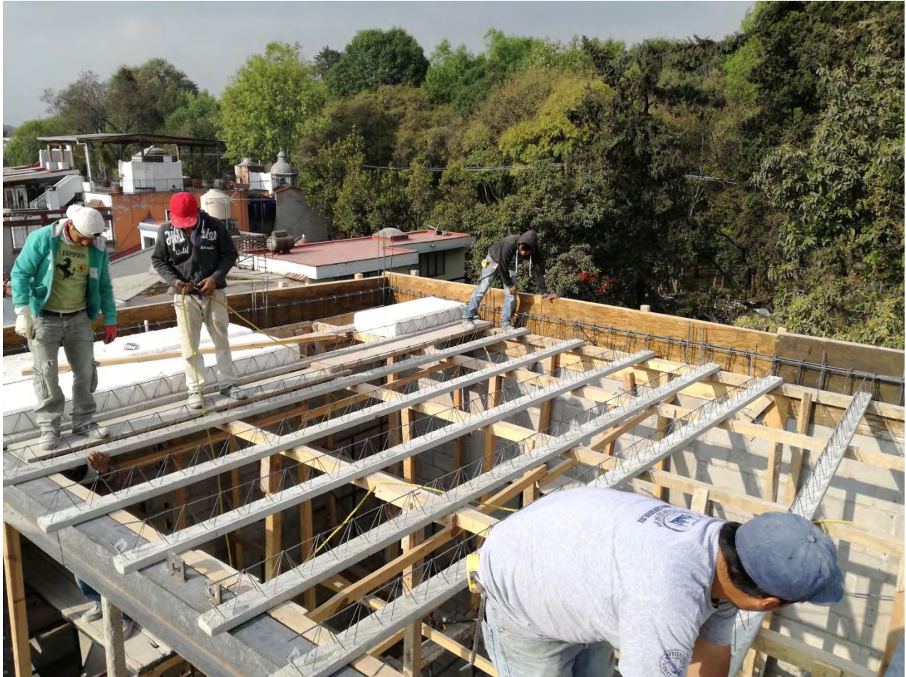
Imágenes 122,123, 124 y 125: Tendido, elevado de tubería, proceso del colado y colocación de vigueta y bovedilla.
