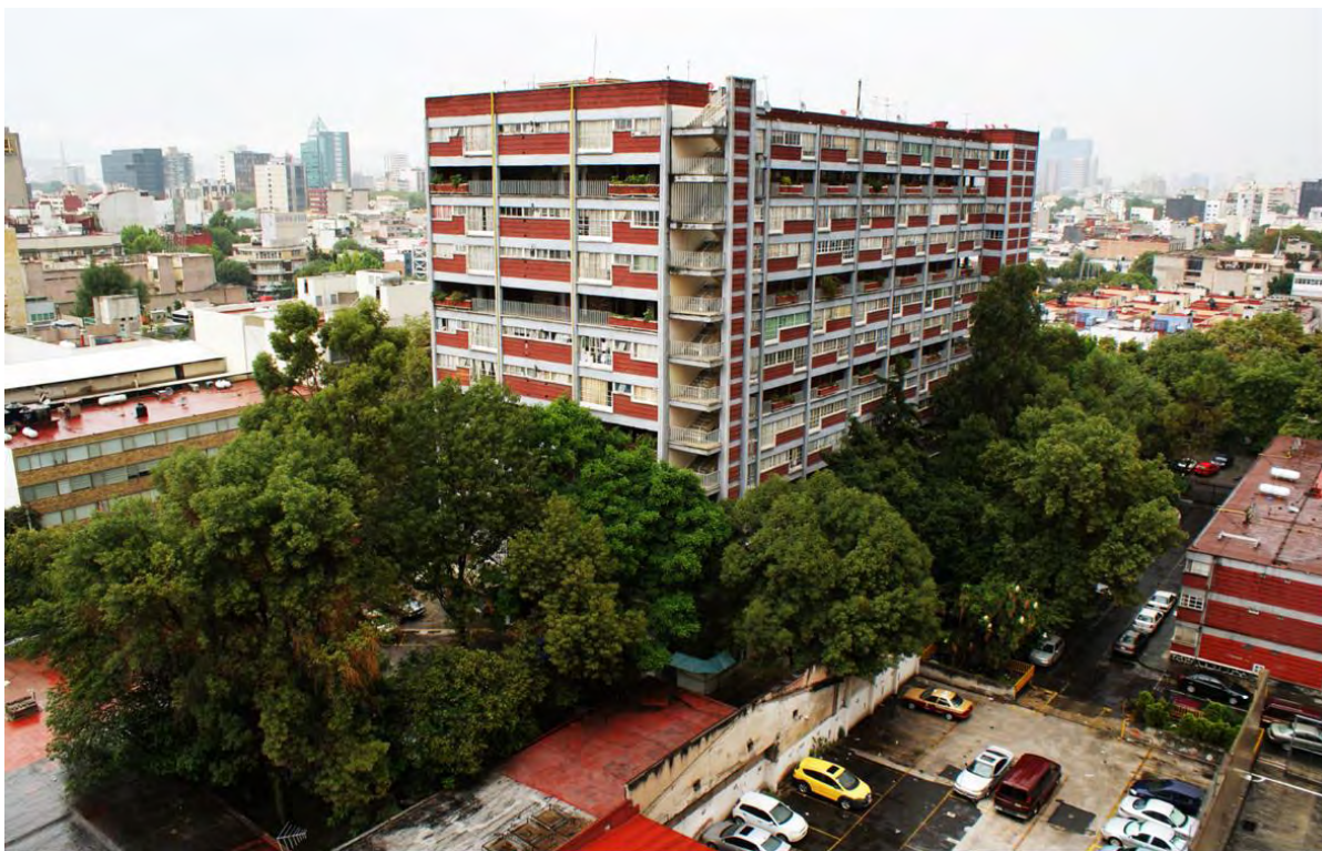
Imagen 14: El CUPA (Centro urbano presidente Alemán) es un ejemplo de una edificación destinada a vivienda de tipo multifamiliar.
