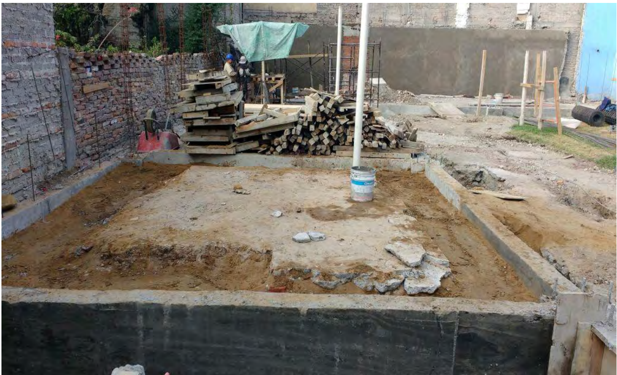
Imagen 65: Zapatas y trabes de liga coladas.
