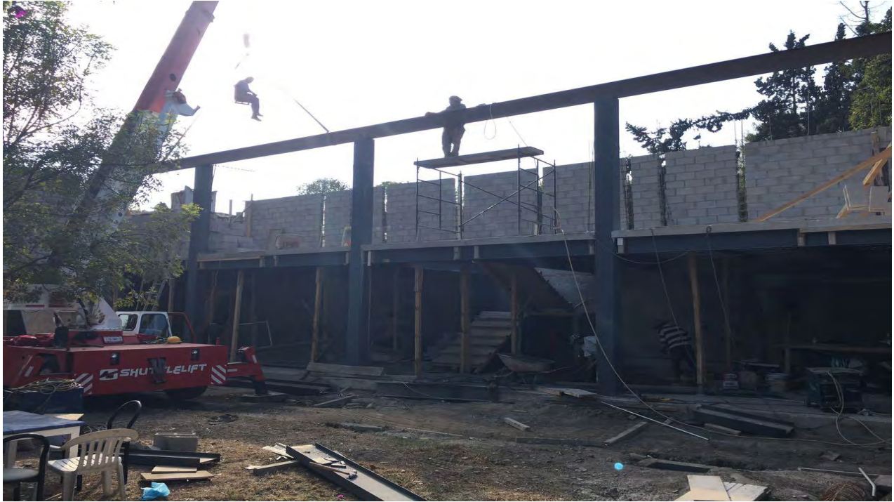
Imágenes 109, 110, 111 y 112: Levantamiento de muros del primer nivel y montaje de viga de cierre.
