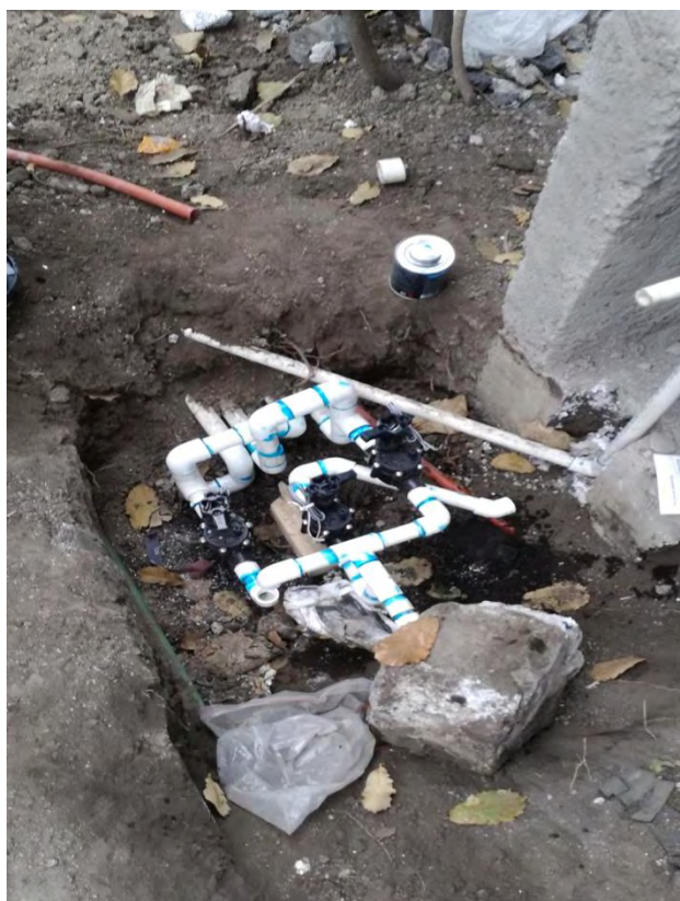
Imágenes 183 y 184: Tendido de tuberías de riego automático y controlador del sistema.
