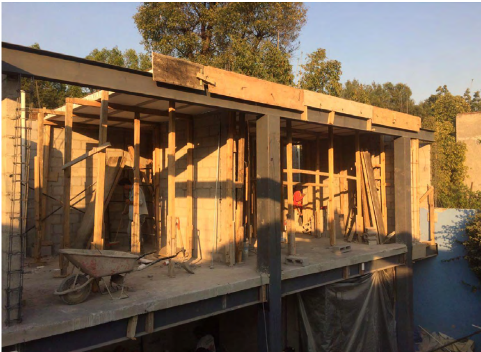
Imágenes 119 y 120: Apuntalamiento y cacheteado de vigueta y bovedilla
