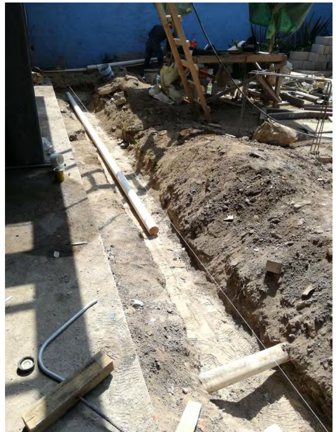
Imágenes 59 y 60: Excavación para los registros hidrosanitarios.
