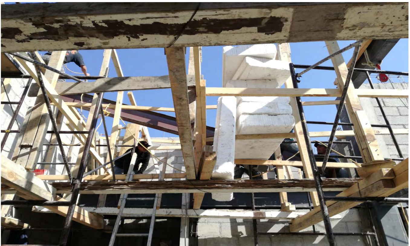
Imágenes 129, 130, 131 y 132: Apuntalamiento de losa Mezzanine y armado de losa maciza.
