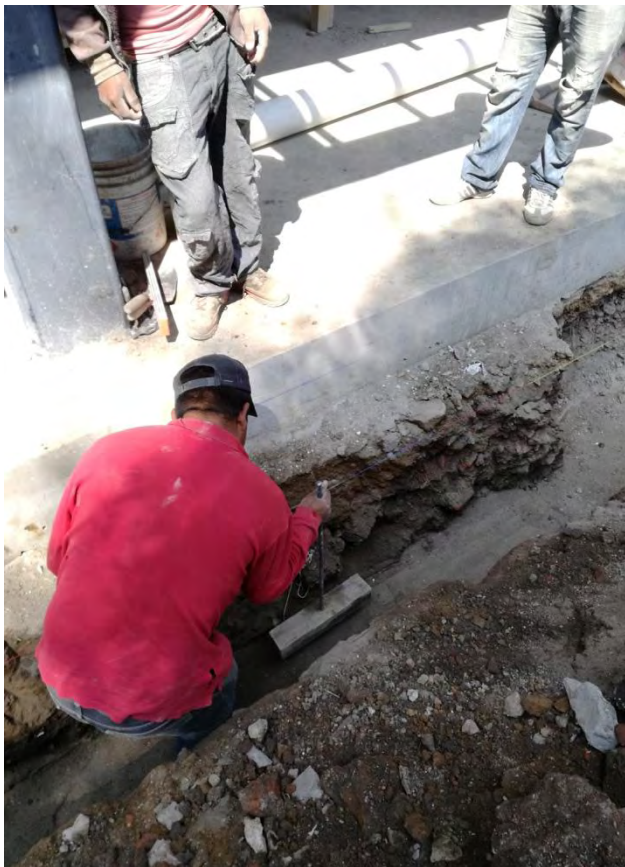
Imágenes 59 y 60: Excavación para los registros hidrosanitarios.
