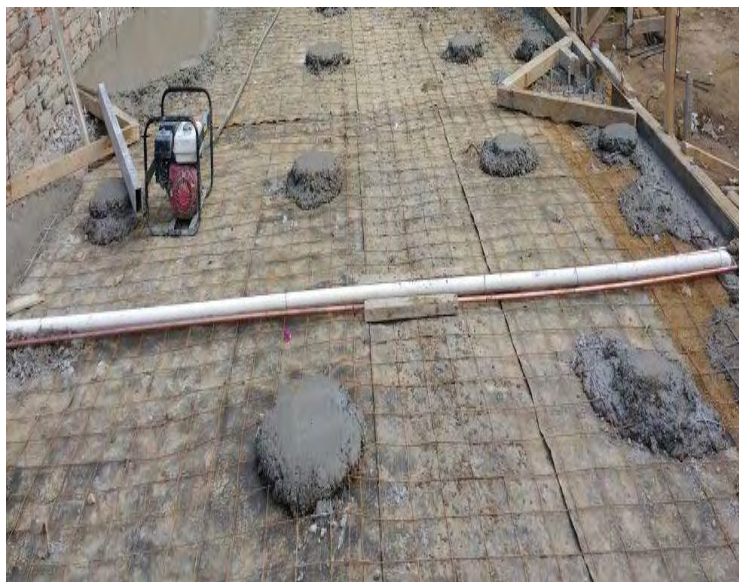
Imágenes 67 y 68: Instalaciones hidrosanitarias en firme de planta baja.
