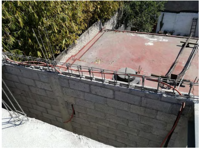
Imágenes 133 y 134: Cadena perimetral con instalación eléctrica y placas de acero soldadas a cadena perimetral.
