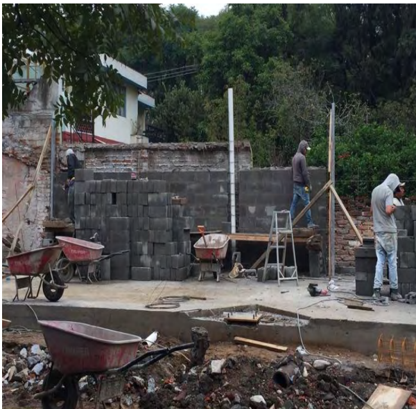
Imágenes 78 y 79: Avance de muro perimetral planta baja, también se aprecian las bajadas de tubería de planta alta.
