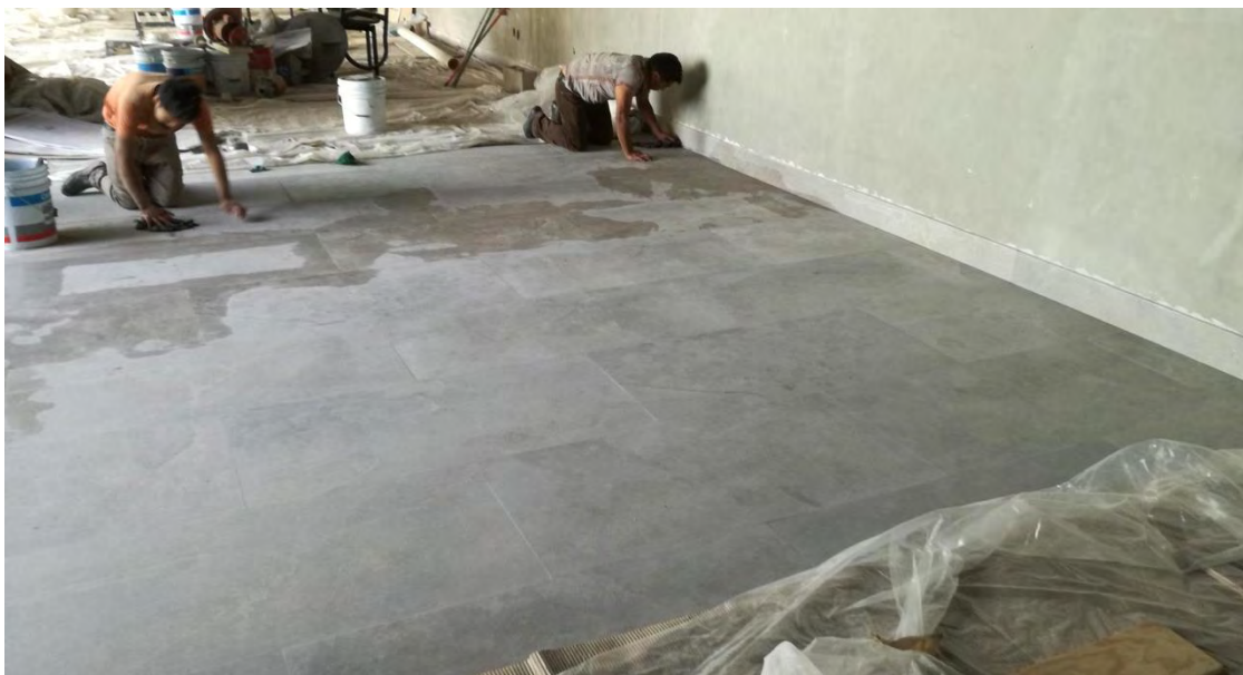
Imágenes 177, 178 y 179: Proceso de colocación de porcelanato en P.B.
