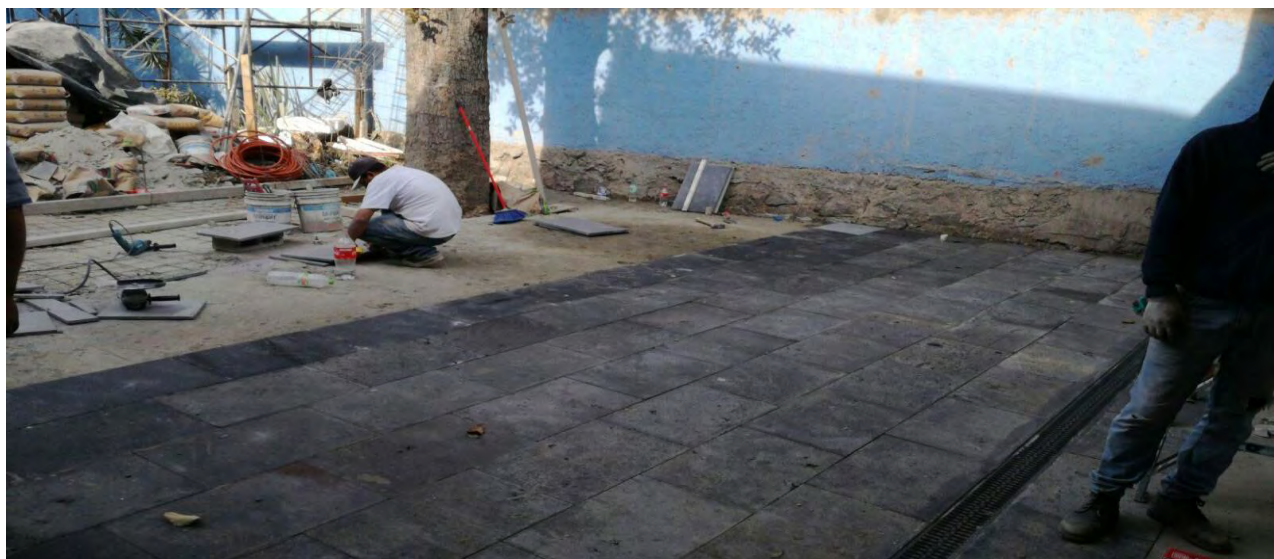
Imágenes 180, 181 y 182: Colocación de plantilla de concreto, canaleta de captación y recinto en exterior P.B.
