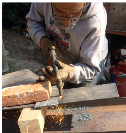
Imágenes 84, 85, 86 y 87: Montaje de vigas y proceso de oxicorte.
