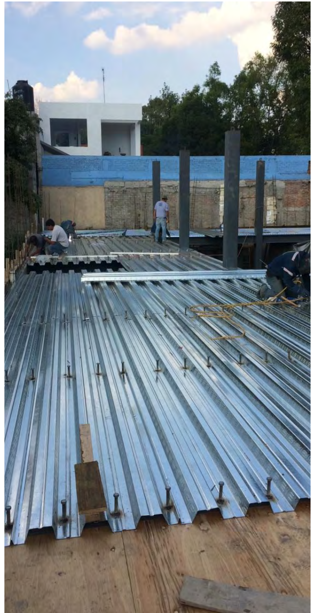
Imágenes 92 y 93: Posición de las láminas de la losacero
