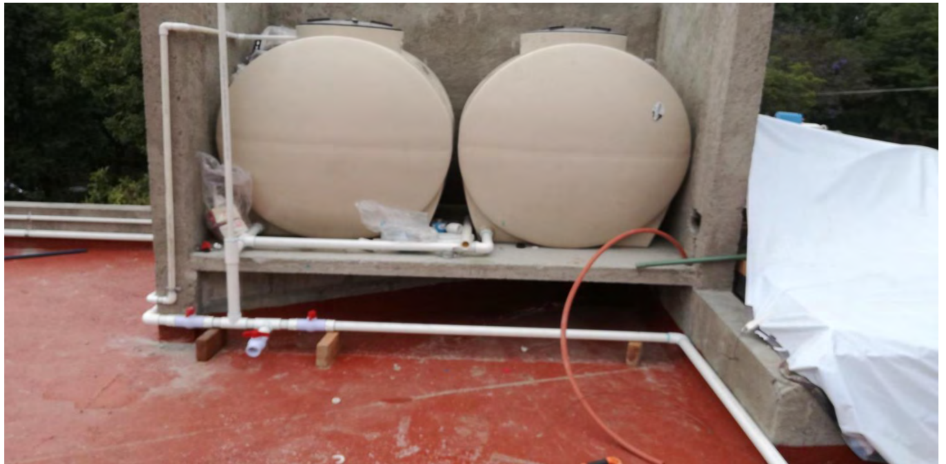
Imágenes 135, 136, 137, 138, 139 y 1140: Poleas para elevar los botes con concreto, colado, vibrado y enrasado de losa mezzanine instalación de tinacos.
