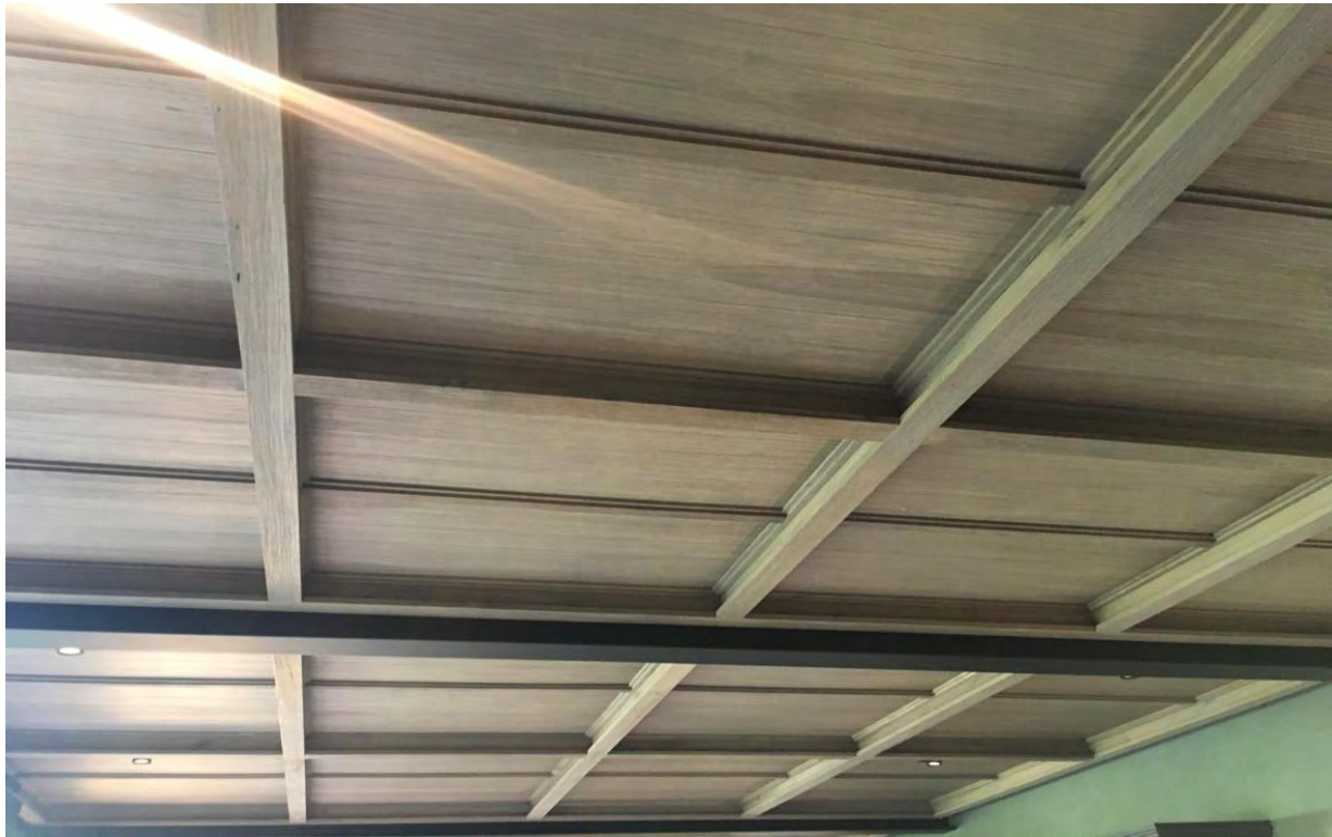
Imágenes 194, 195 y 196: Instalación y acabado del plafón de cubos.
