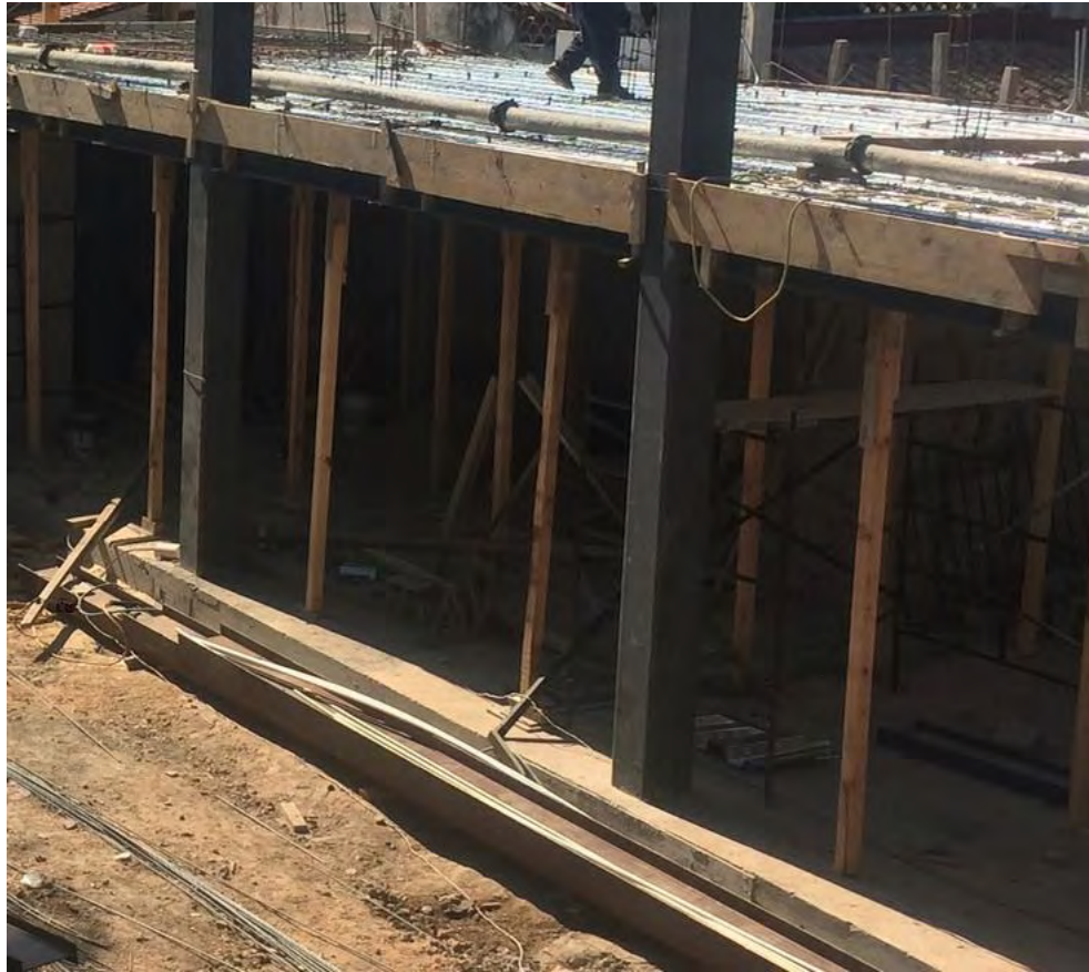
Imagen 101: Apuntalamiento de losacero
