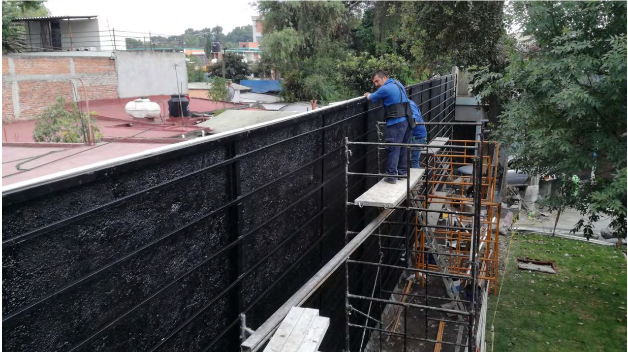
Imágenes 208 y 209: Refuerzo y bastidor de muro verde.
