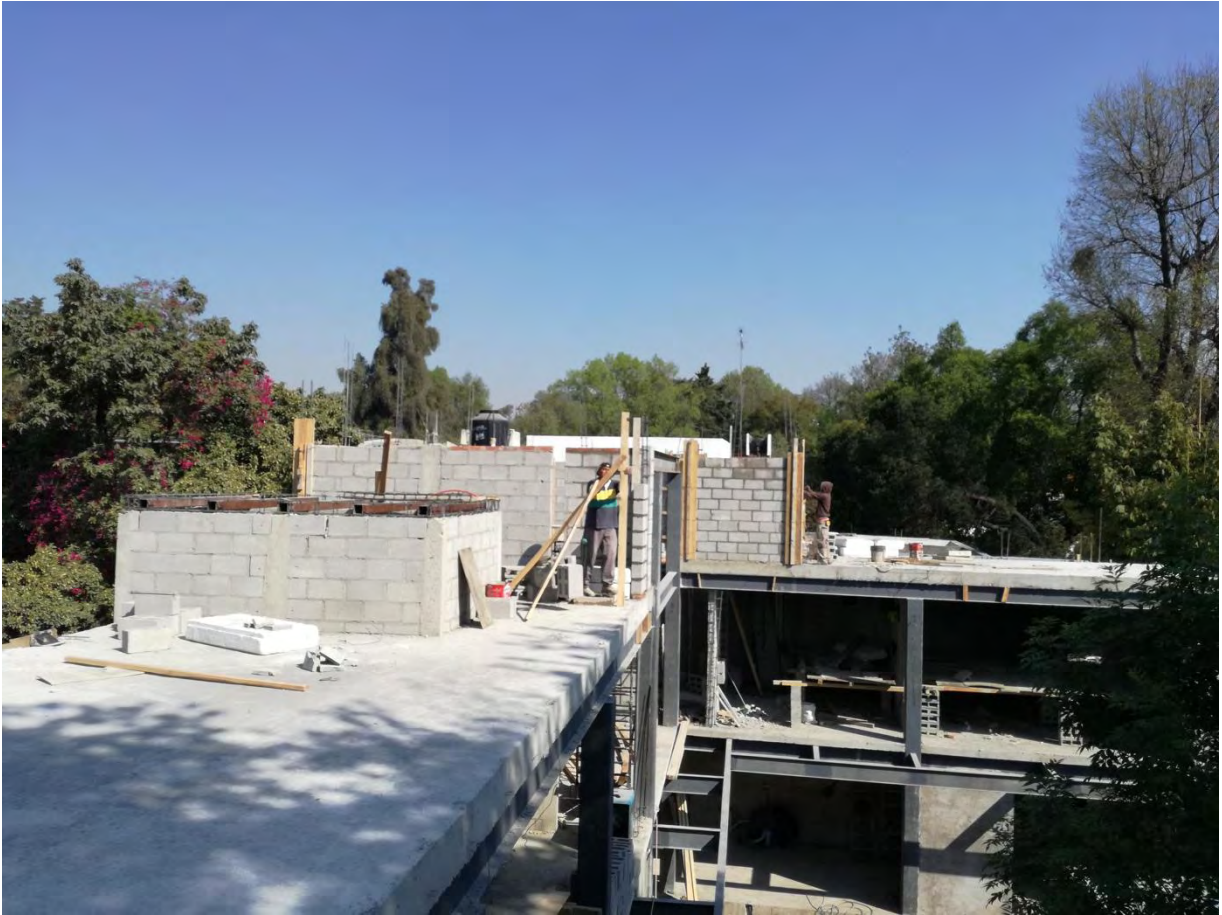
Imágenes 126, 127 y 128: Levantamiento de muros y viga de cierre Mezzanine.
