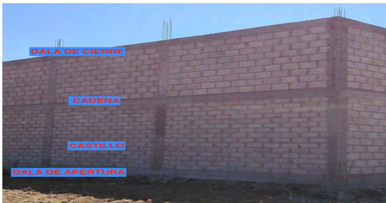
Imagen 73: Componentes de los muros de block.
