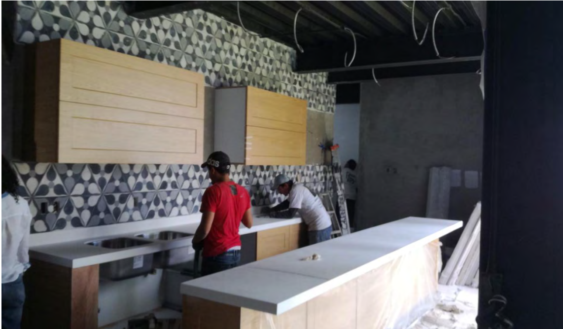
Imagen 197: Instalación de los muebles del área de cocina.
