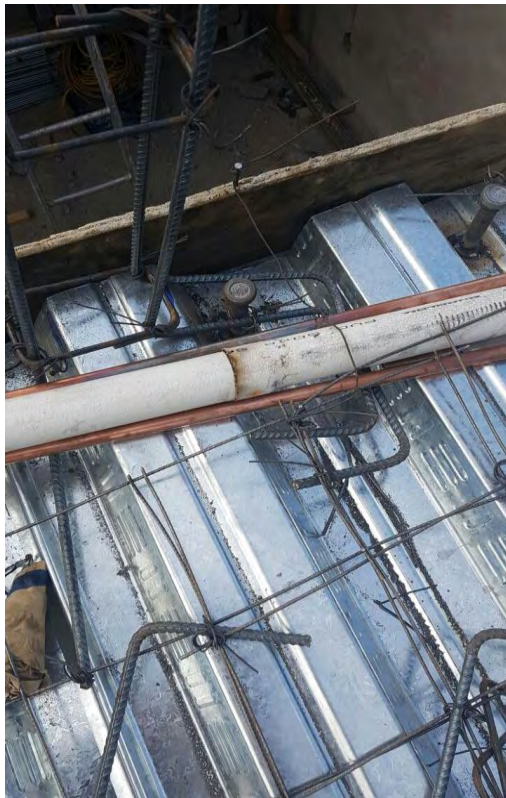
Imágenes 97 y 98: Instalaciones hidrosanitarias y eléctricas en losacero.
