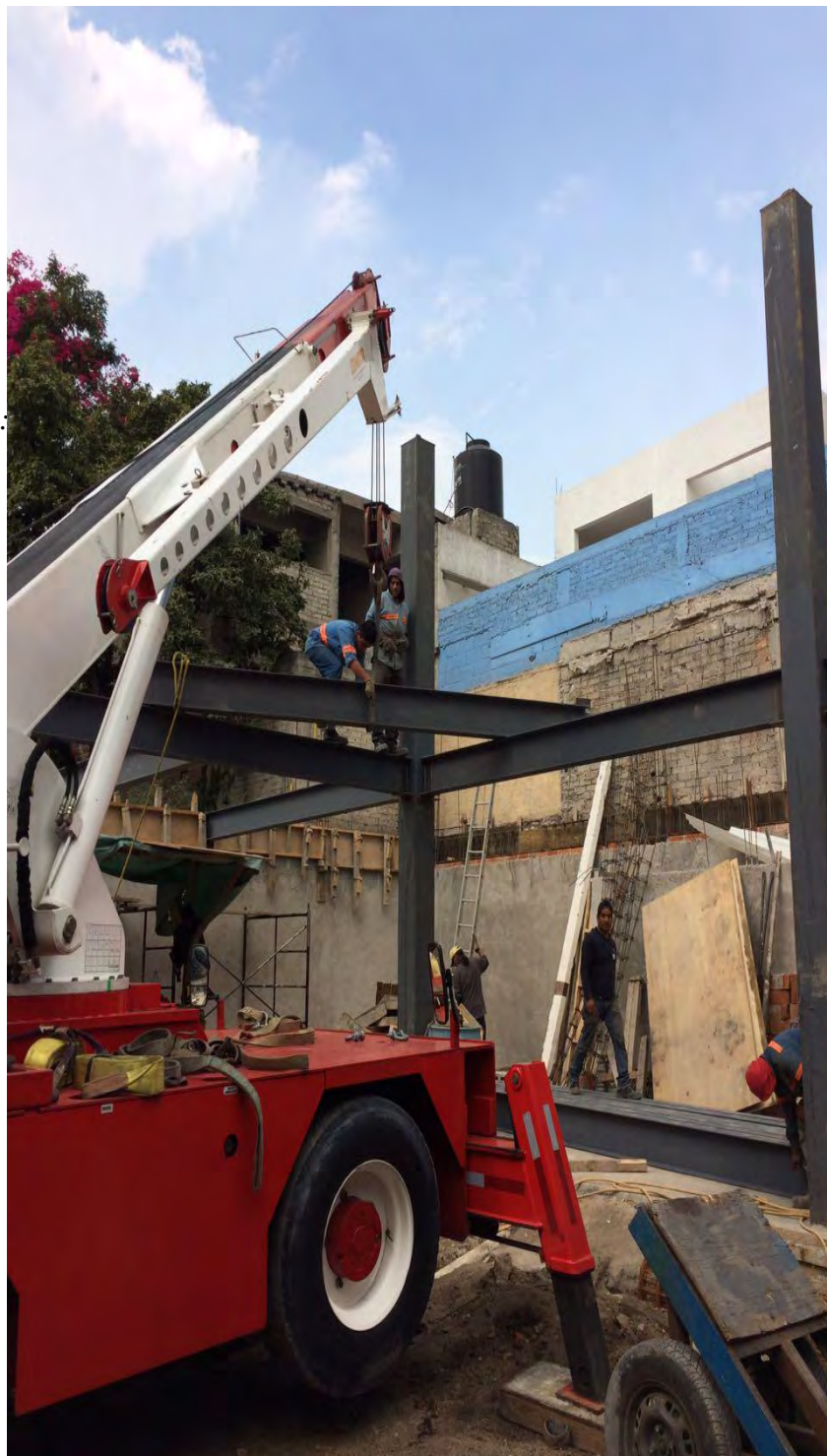
Imágenes 84, 85, 86 y 87: Montaje de vigas y proceso de oxicorte.
