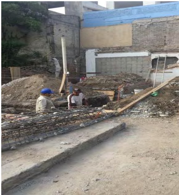
Imágenes 54, 55 y 56: Excavación para la cimentación
