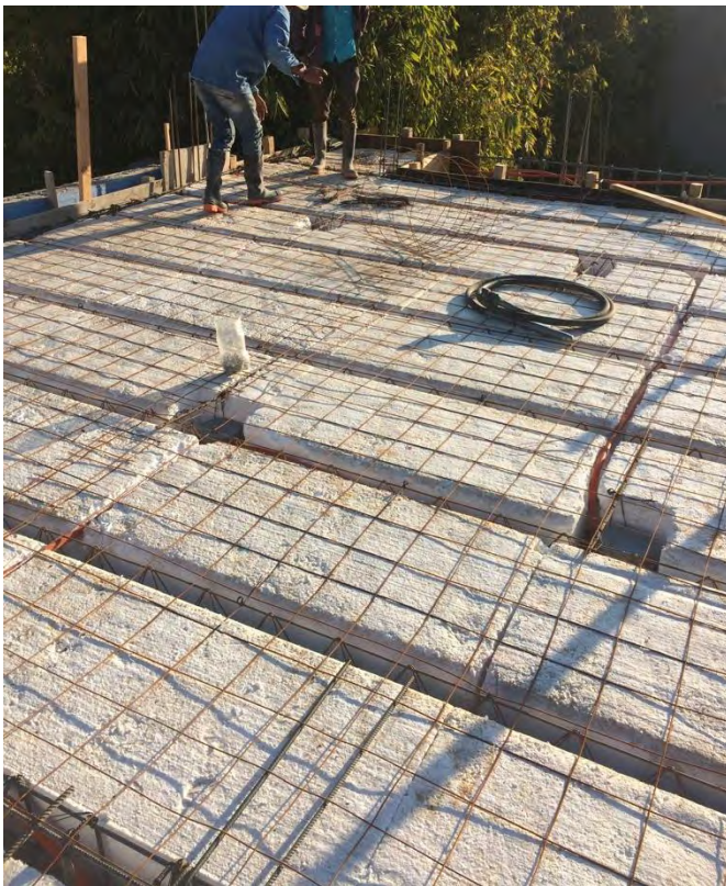
Imágenes 115 y 116: Viguetas y bovedillas colocadas, donde también se puede apreciar la instalación eléctrica.
