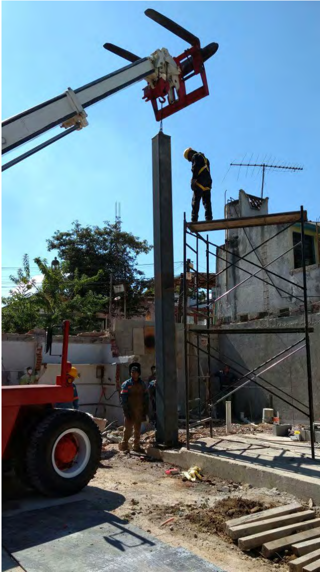
Imagen 81 y 82 : Levantamiento de columnas de acero
