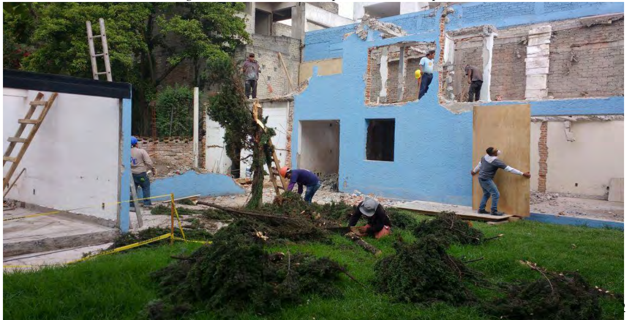
Imagen 49: demolición de planta baja cuerpos A y B.
