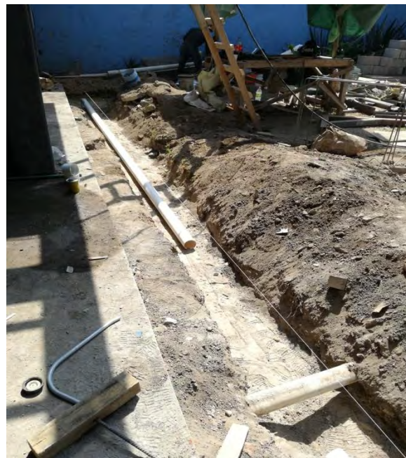
Imágenes 143 y 144: Excavación para registro y tendido de tubería.
