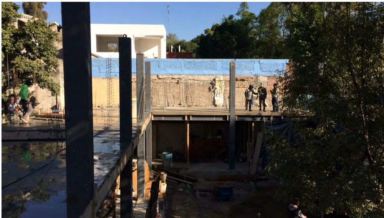
Imágenes 106, 107 y 108: Losa de primer nivel colada.
