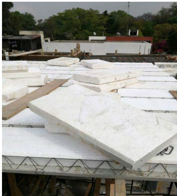
Imágenes 113 y 114: Detalle de armado de losa de vigueta y bovedilla y elementos en sitio
