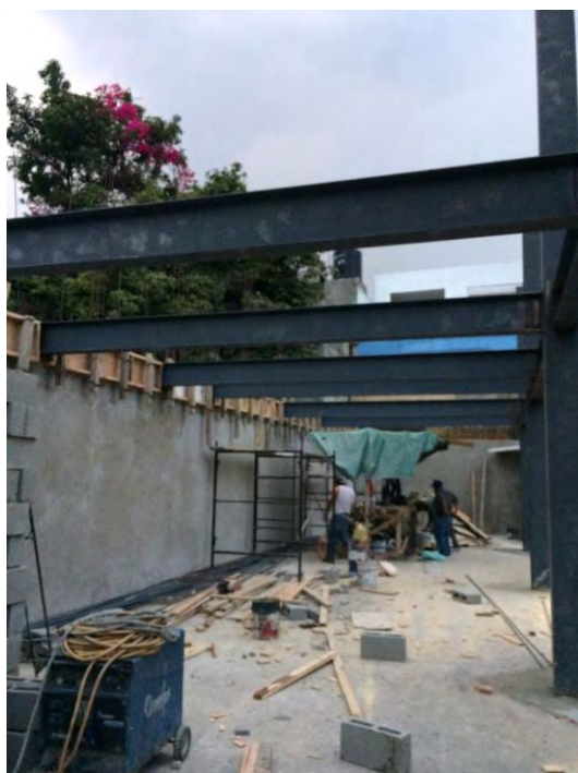
Imágenes 88, 89 y 90: Estructura de acero para primera planta montada
