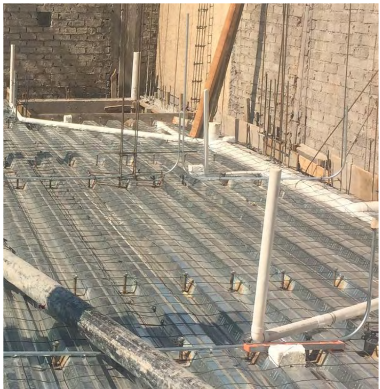
Imágenes 97 y 98: Instalaciones hidrosanitarias y eléctricas en losacero.
