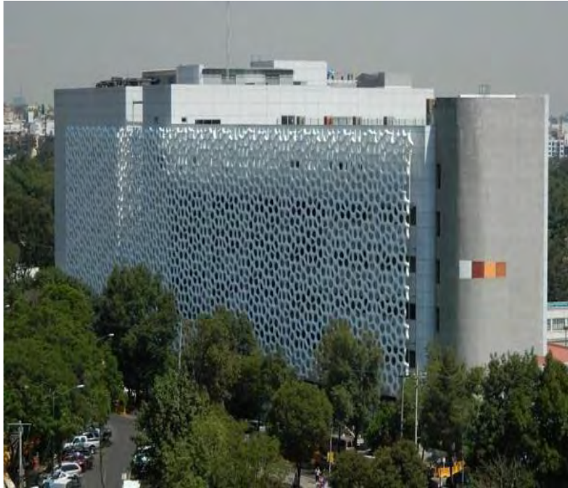
Imágenes 10 y 11: Detalle de azulejo implementado en fachada y edificio principal del hospital.
