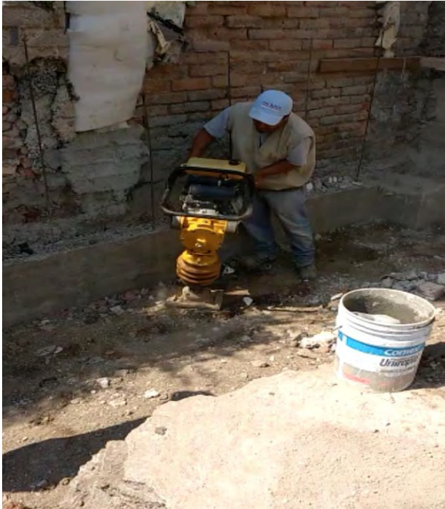
Imagen 71: Compactación de material con apoyo de pisón mecánico
