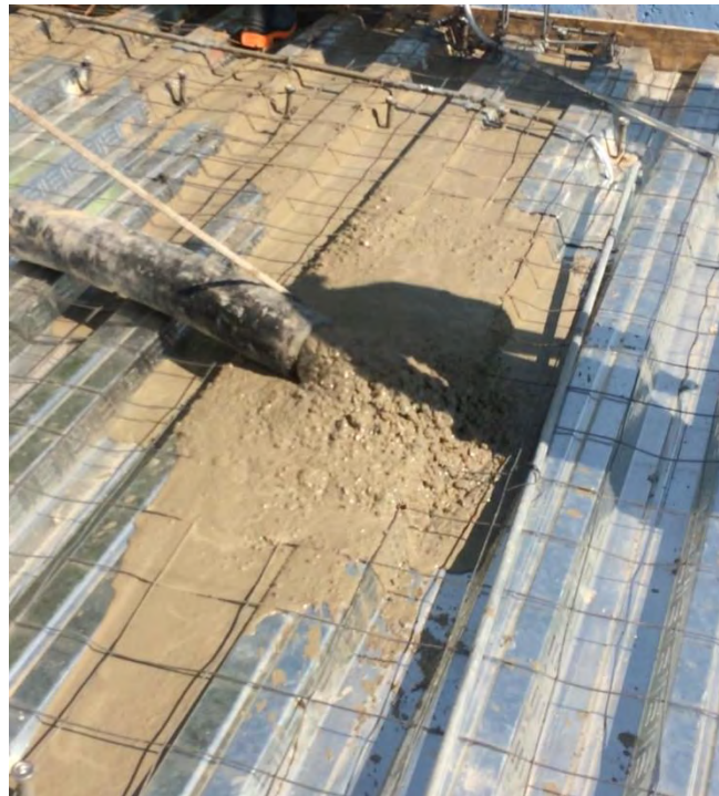
Imágenes 102 y 103: Tendido de tubería y comienzo del colado
