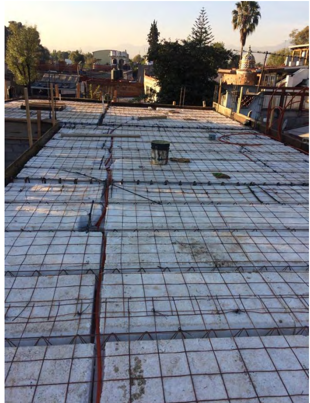
Imágenes 115 y 116: Viguetas y bovedillas colocadas, donde también se puede apreciar la instalación eléctrica.
