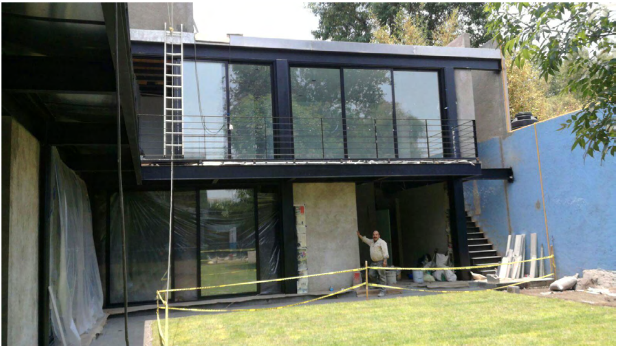
Imágenes 206 y 207: Cancelería en proceso de colocación planta baja y cancelería colocada en planta alta.
