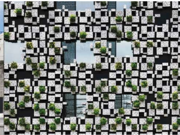
Detalle de fachada
